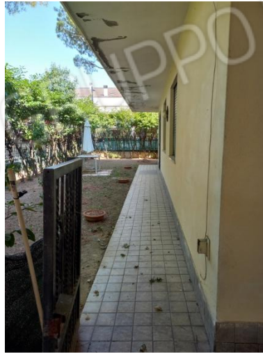
FOTO 8 ESTERNO LATO OVEST
