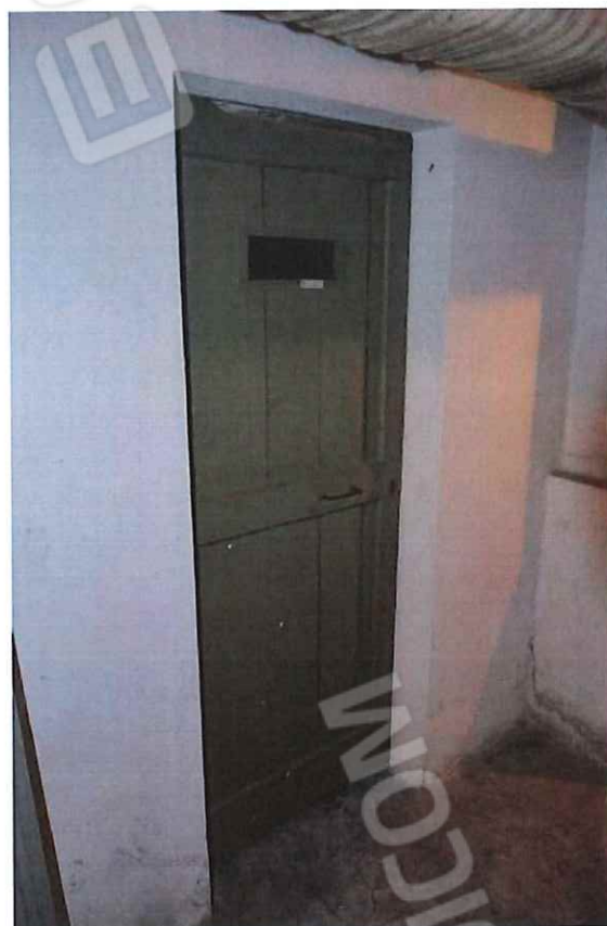
24. porta di accesso cantina
