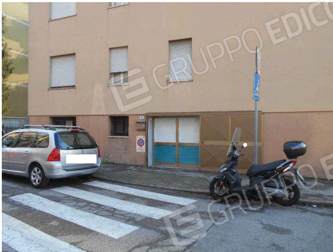
Foto 2: fabbricato condominiale, facciata nord-est, ingresso del magazzino
