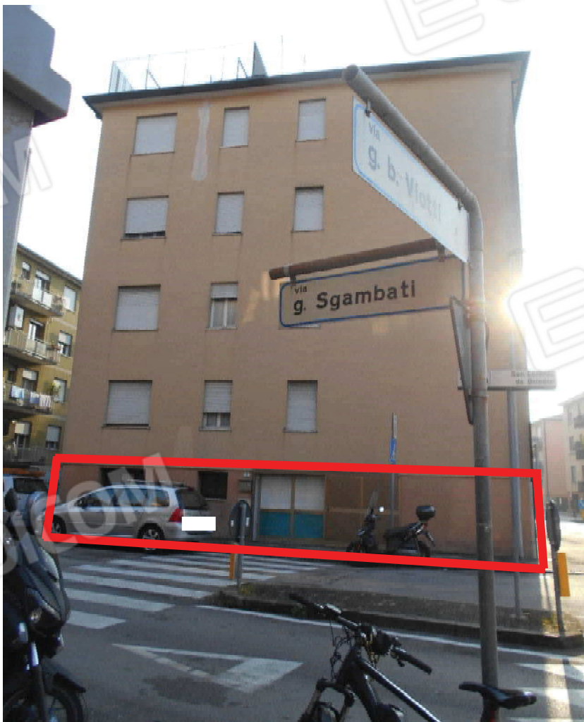
Foto 1: fabbricato condominiale di cui il magazzino fa parte, facciata nord-est verso via Sgambati. Riquadrata in rosso la porzione a magazzino in oggetto
