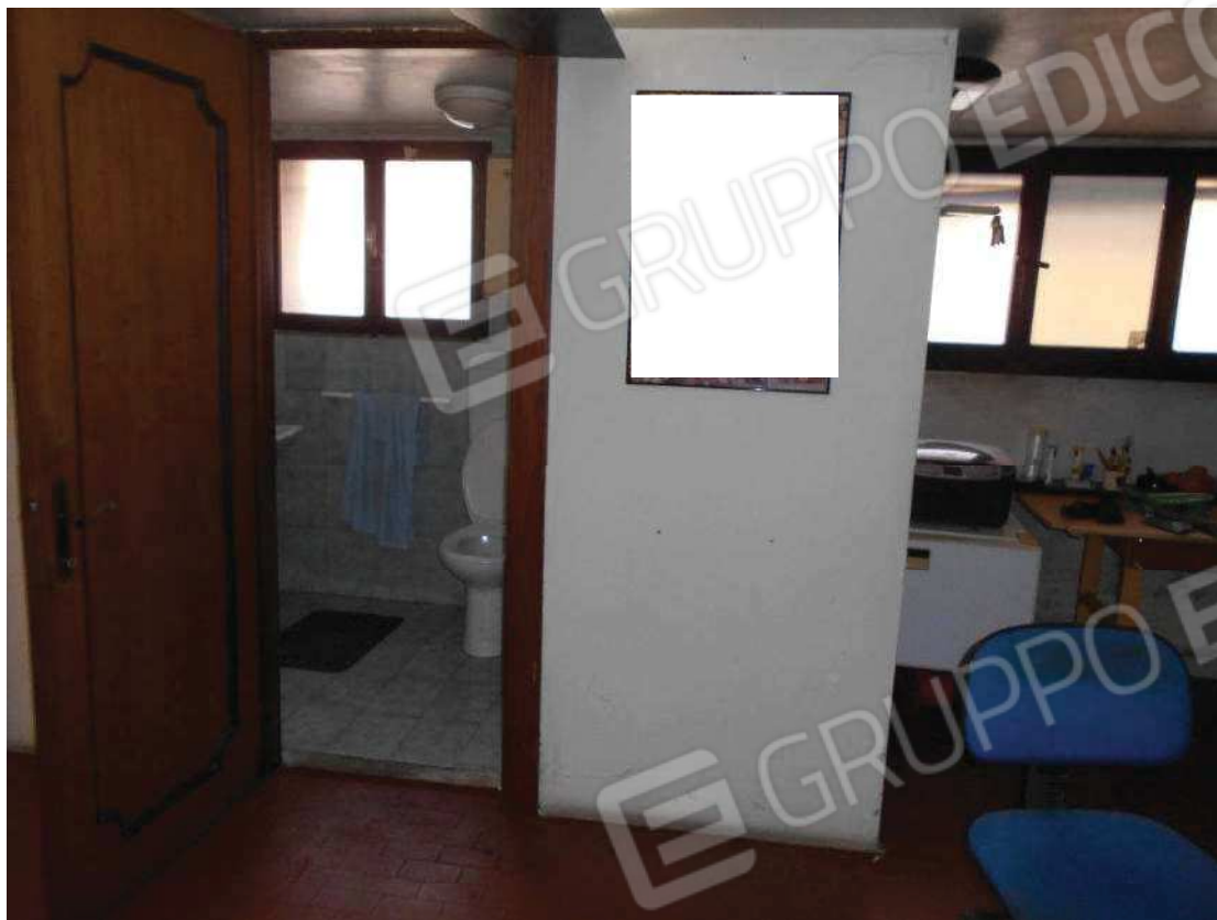
Foto 10: vano più a sud (con wc)
