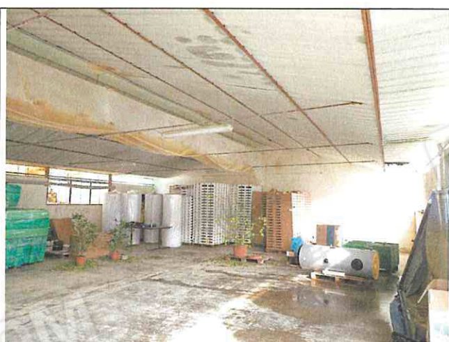
Foto n°48: Fungaia a nord
