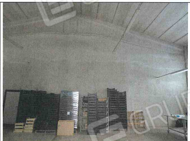
Foto n°139: Interno ricovero prodotti agricoli
