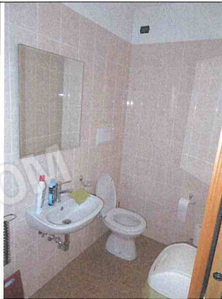
Foto n°84: Servizio igienico interno all'ufficio
