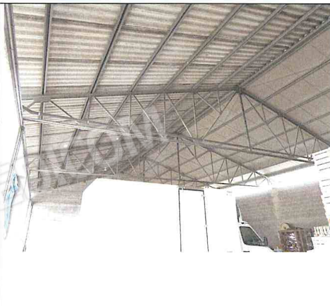
Foto n°120: Copertura edificio E
