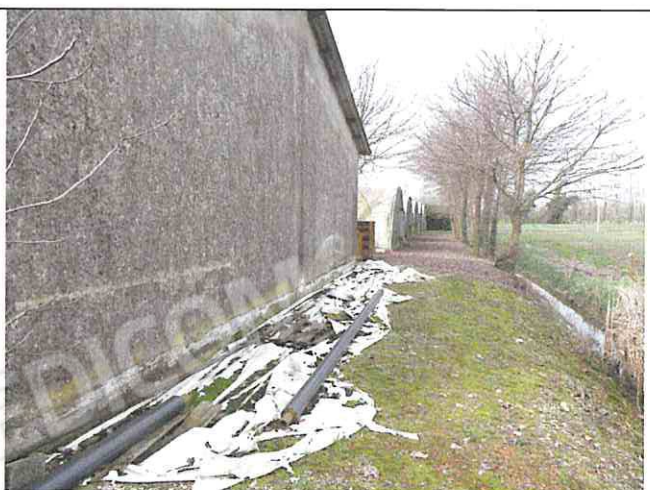
Foto n°44: Prospetto nord, vista estremità mapp. 140
