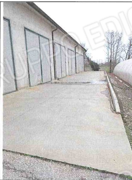
Foto n°159: Pavimentazione esterna est
