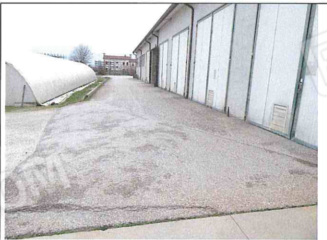
Foto n°160: Pavimentazione esterna est
