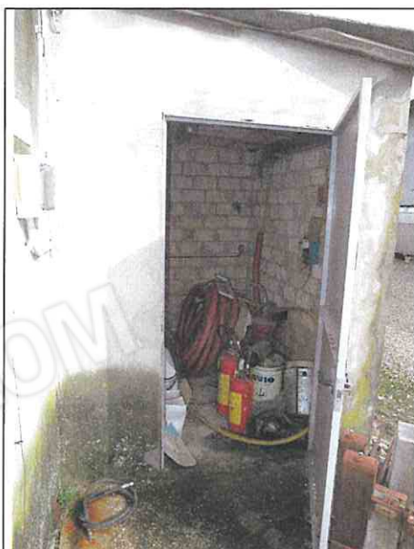
Foto n°72: Accesso allo ripostiglio a sud-est
