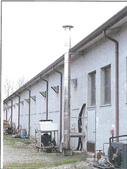
Foto n°128: Particolare prospetto ovest – C.T.
