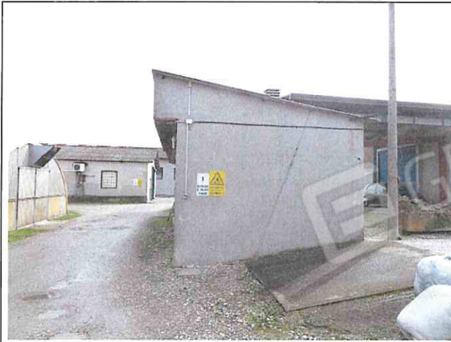
Foto n°93: Vista ovest Corpo C
