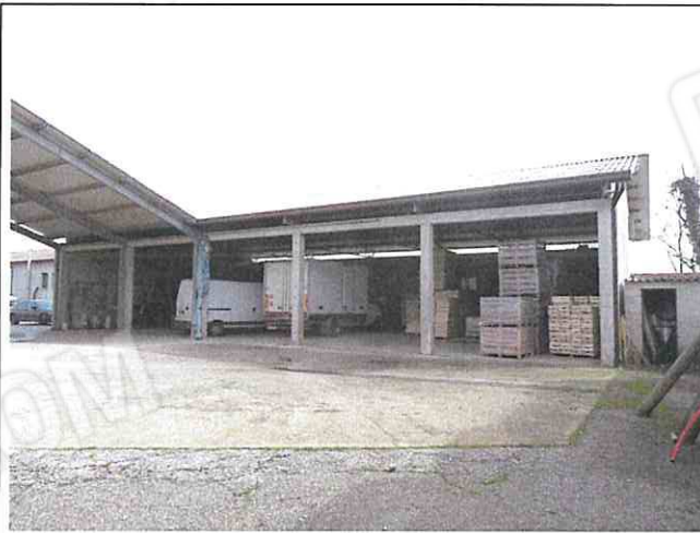
Foto n°118: Tettoie di connessione ed edificio E
