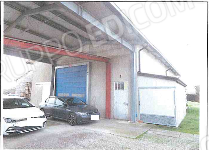
Foto n°94: Edificio B con tettoia a connettivo
