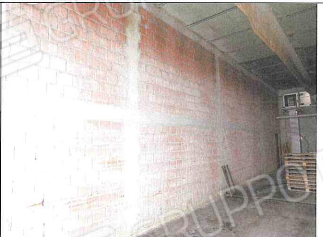
Foto n°149: Murature divisorie camera di incubazione
