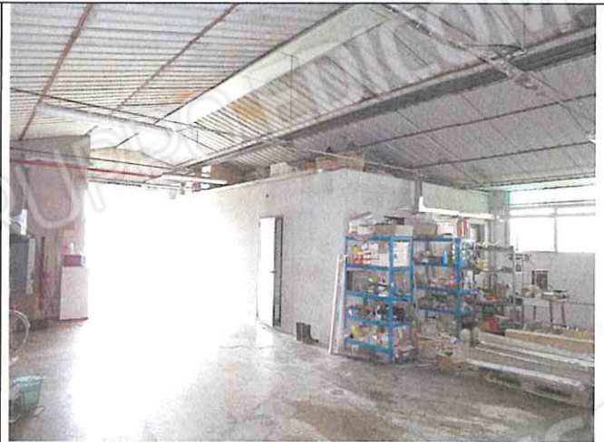
Foto n°77: Vista edificio uffici e servizio igienico interno
