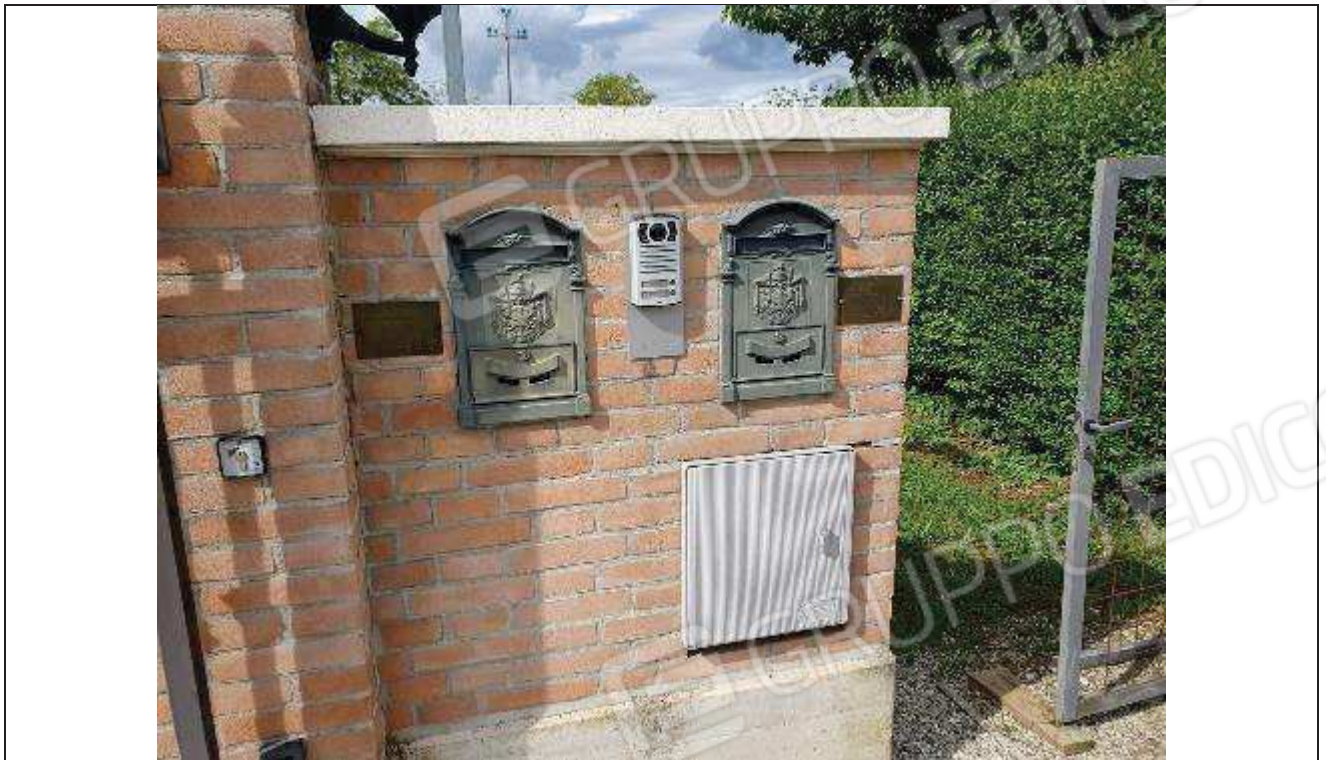
03 Vista della recinzione lungo il fronte stradale;
