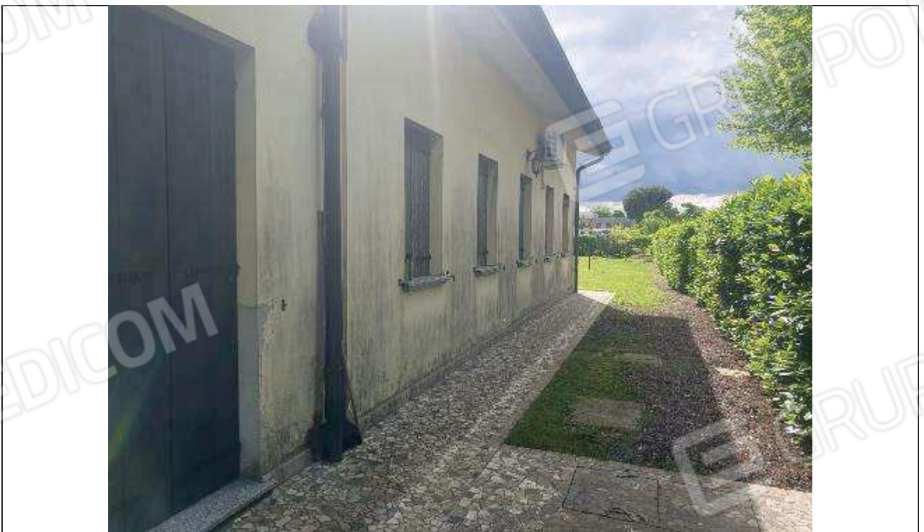
18 Altra vista del lato Nord;
