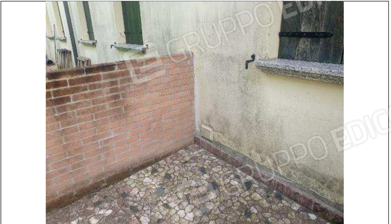
19 Particolare sul muretto posto a confine tra i due immobili lungo il fronte Nord;
