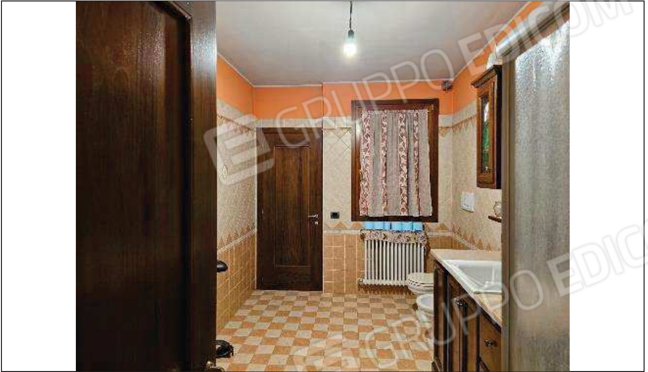
41 Vista della lavanderia/centrale termica, ricavata abusivamente nella porzione del ripostiglio agricolo;
