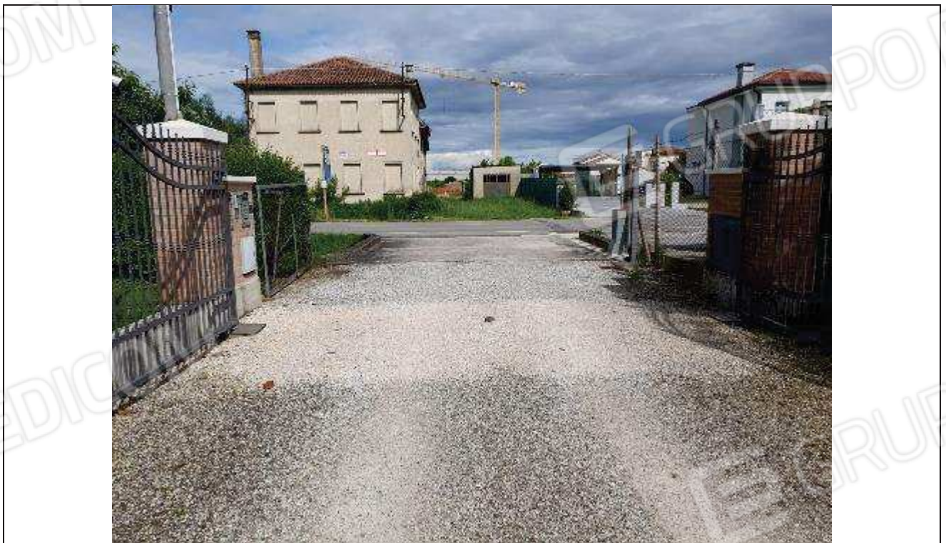
04 Vista del cancello carrabile e pedonale comune alle due unità abitative verso la pubblica via;
