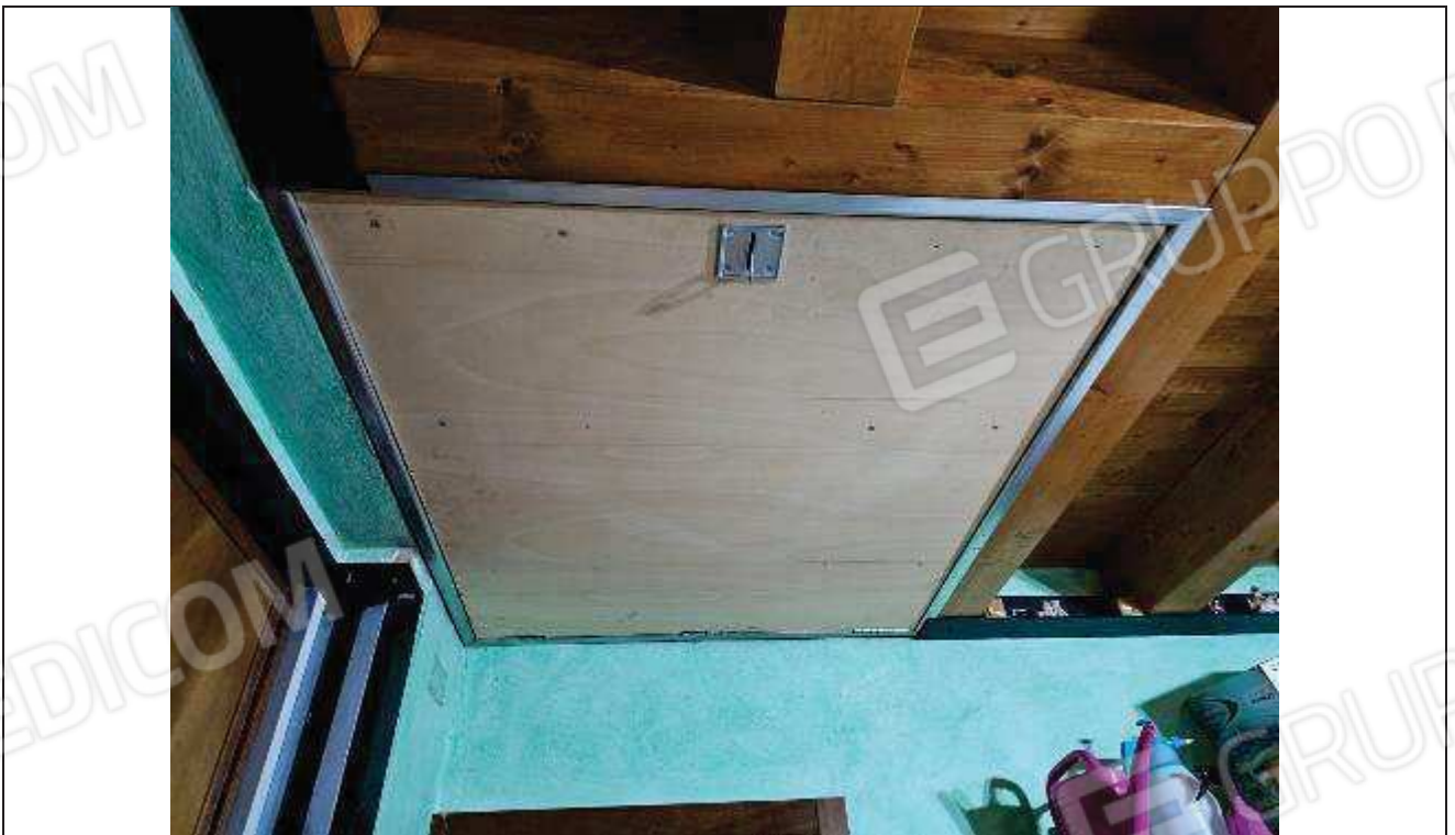
52 Vista della botola con scala retrattile verso il soppalco;
