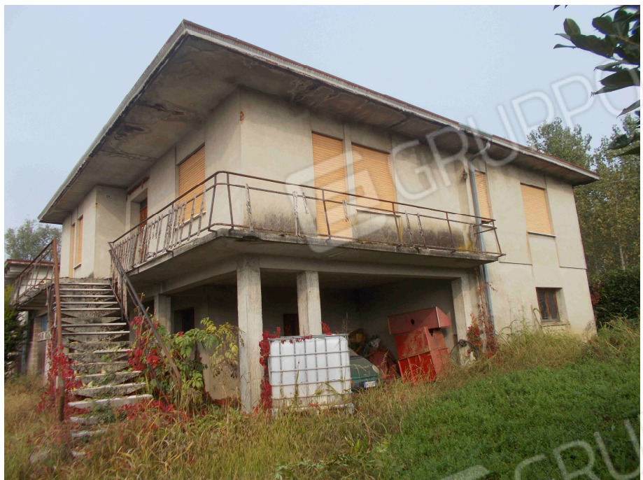
Foto 10- Abitazione da demolire
