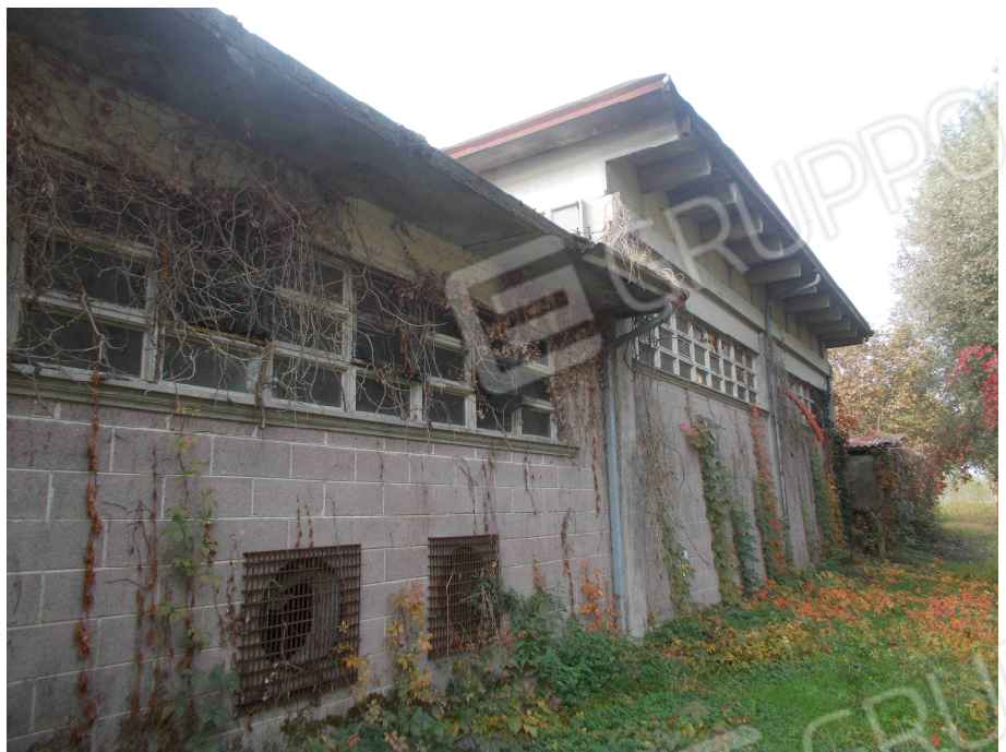
Foto 6- Vista da nord
