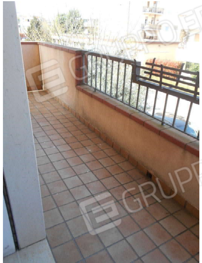
Foto 28: poggiolo piano primo
