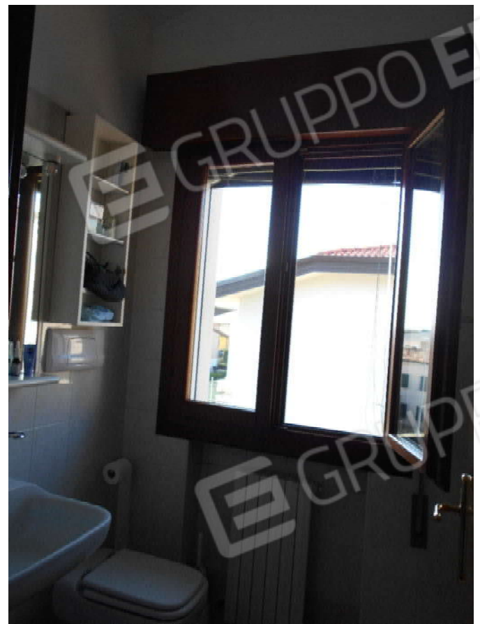
Foto 35: bagno piano sotto-tetto
