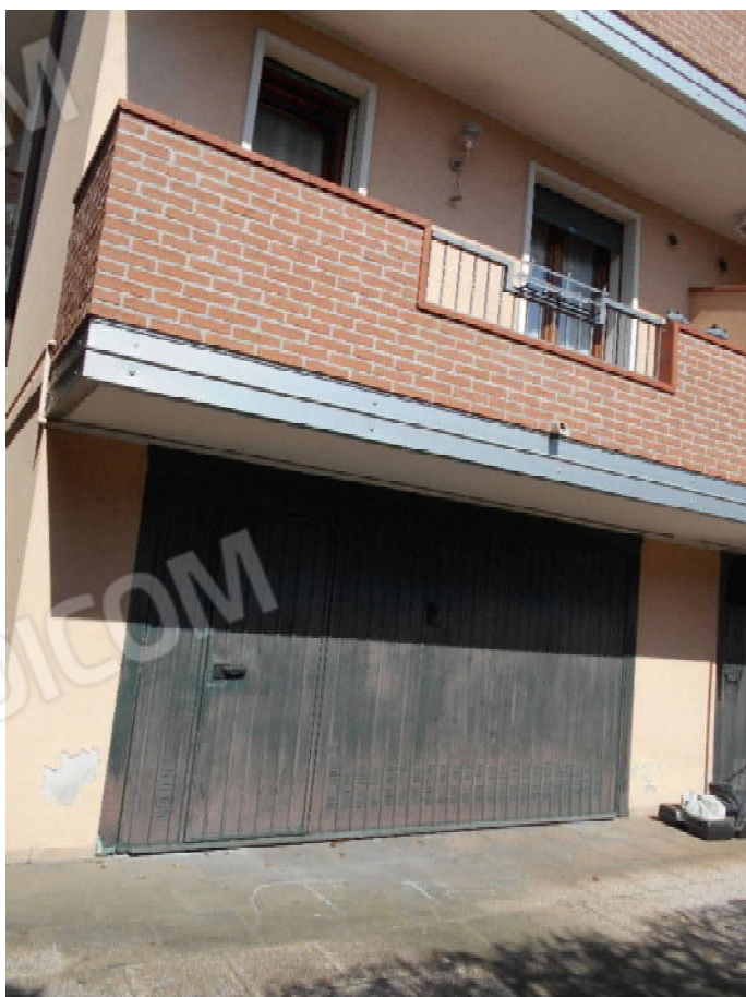
Foto 10: portone garage in oggetto
