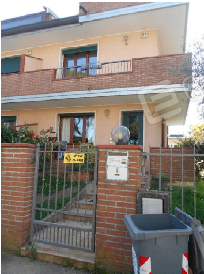
Foto 2: porzione in oggetto, facciata nord su via Bracciano
