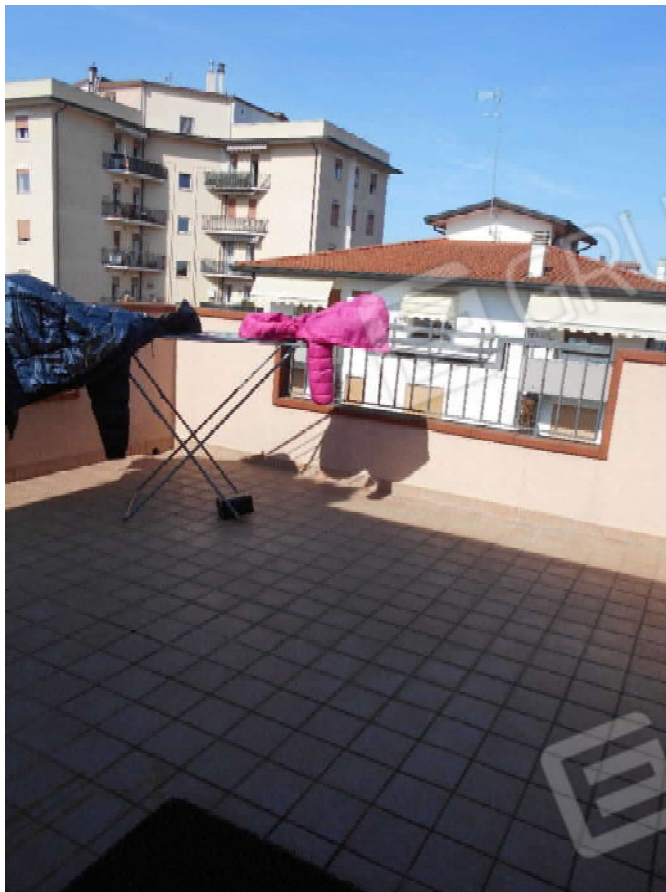
Foto 33: terrazza piano sotto-tetto, lato nord
