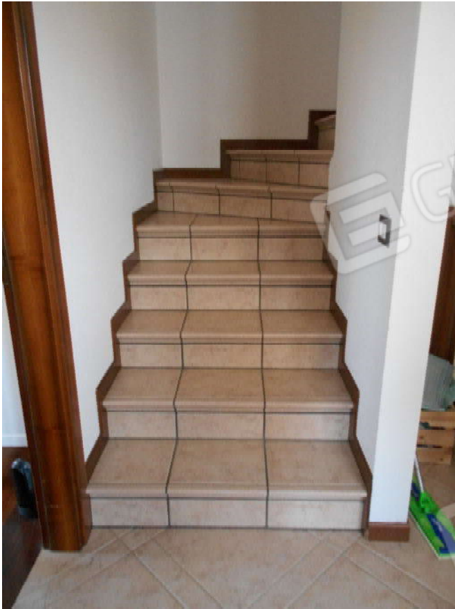
Foto 29: scala dal piano primo verso il piano sotto-tetto
