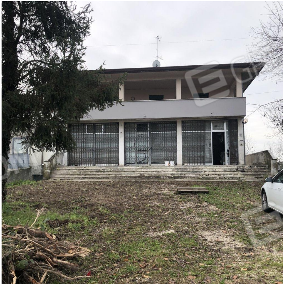
foto n. 18 – area scoperta a nord
