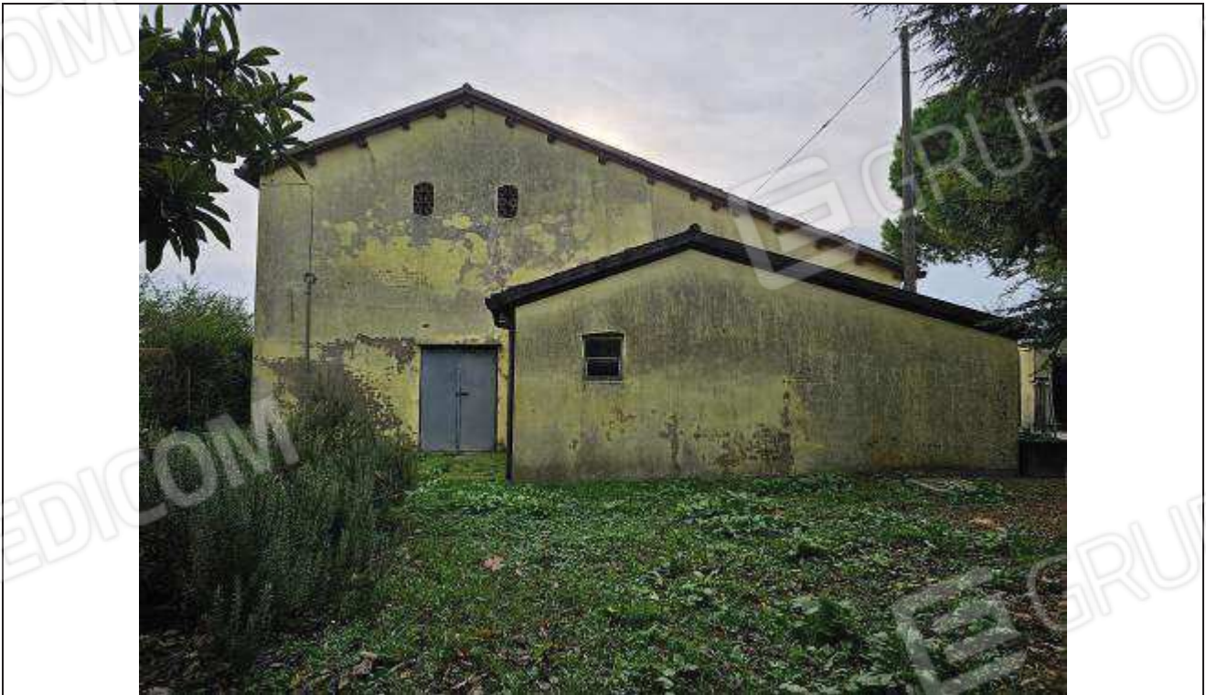
08 Vista del prospetto Nord-Ovest del fabbricato rurale, lato stalla;
