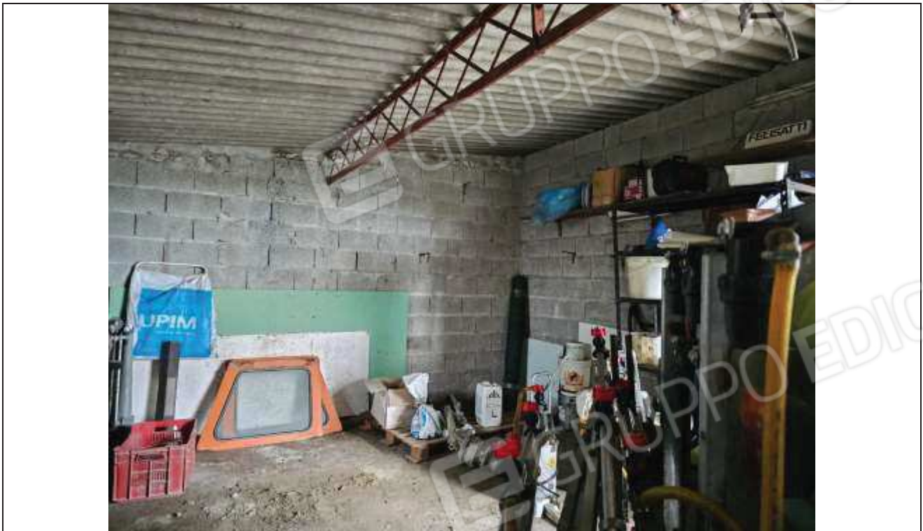
63 Altra vista interna del deposito attrezzi;
