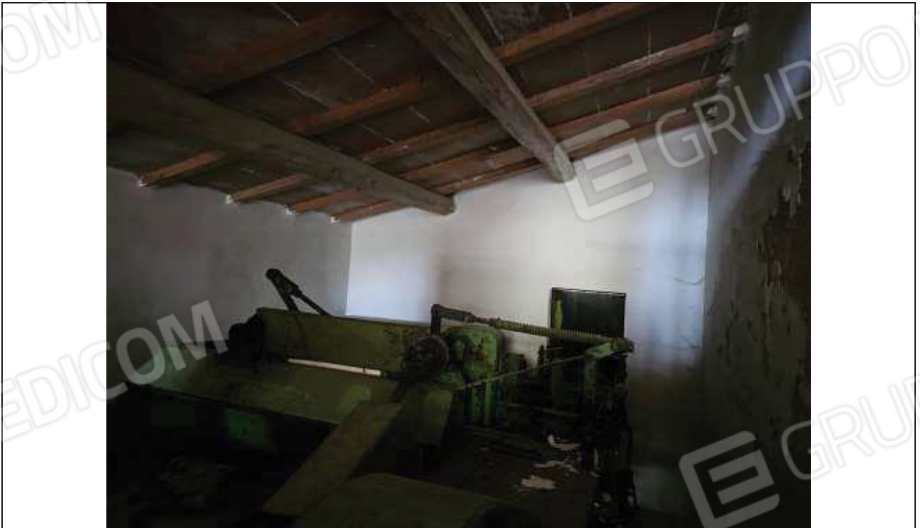
50 Altra vista interna del deposito;
