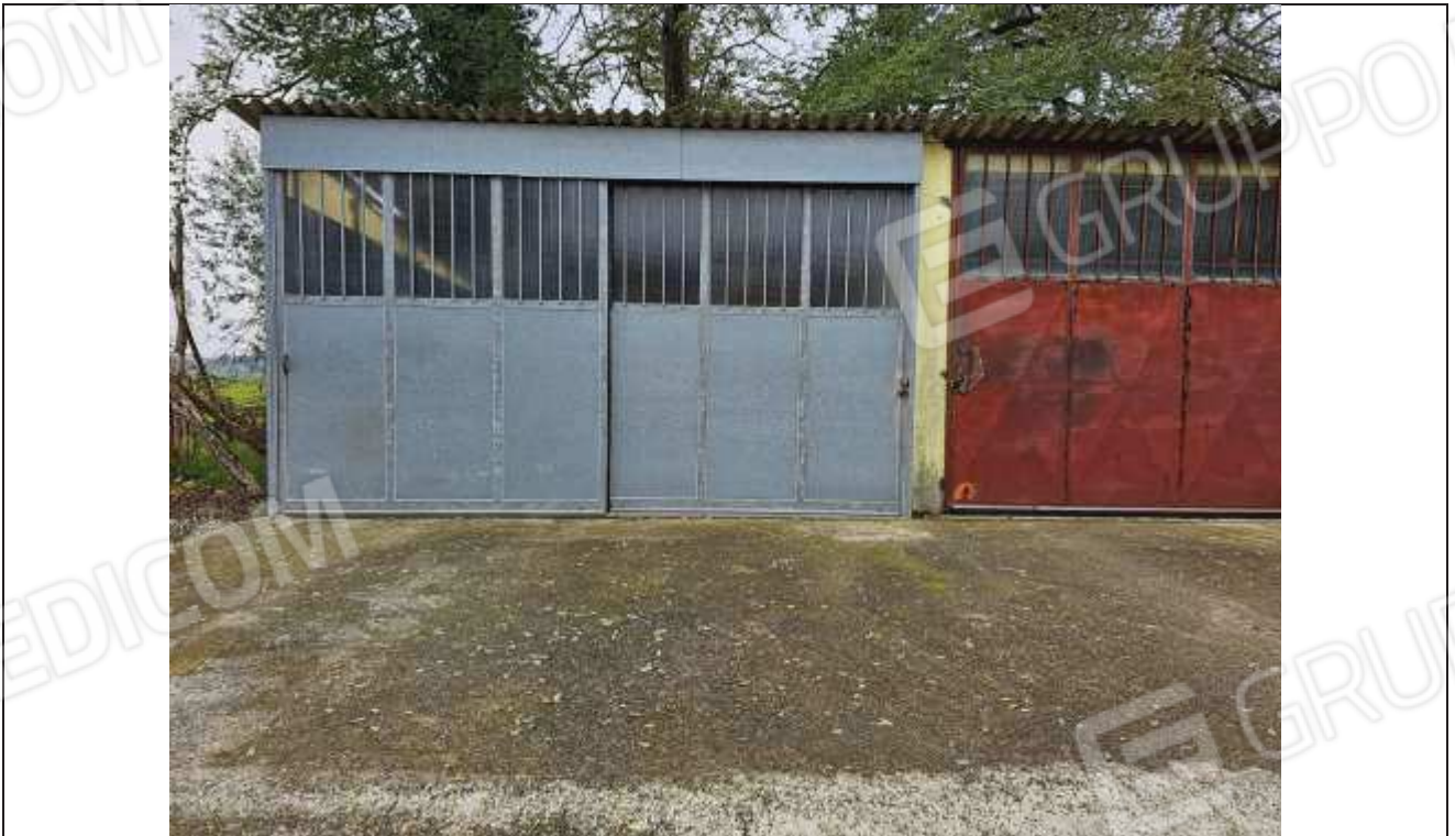
58 Vista del prospetto Nord della porzione in abuso;
