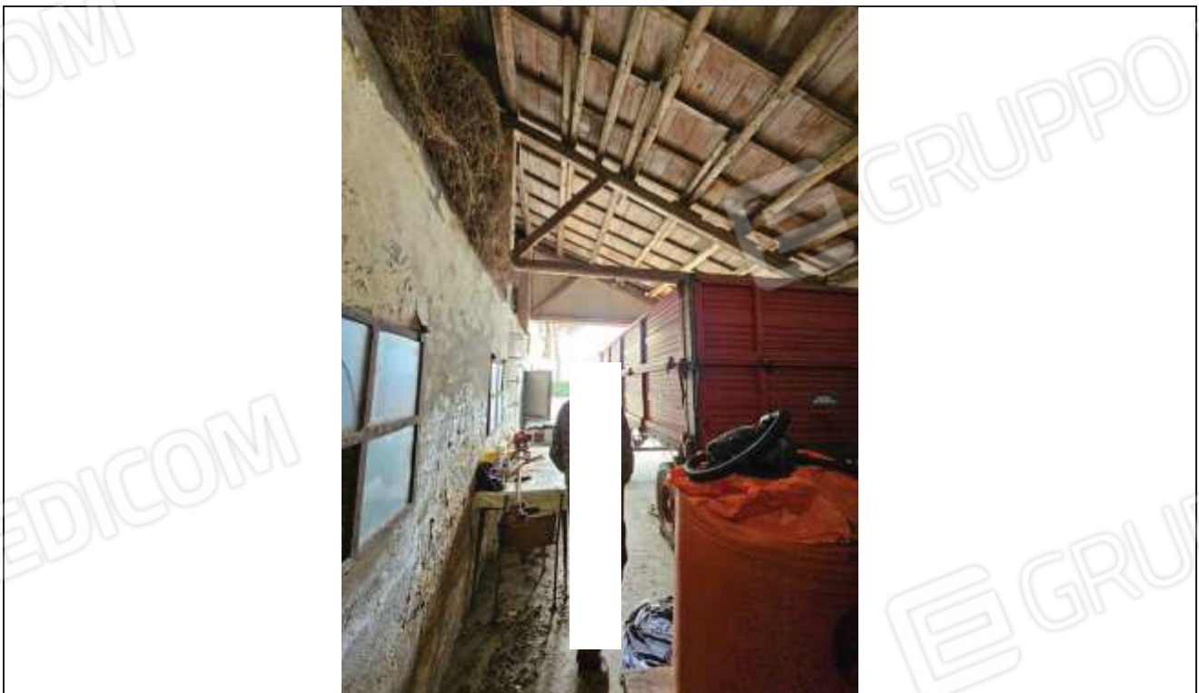
46 Altra vista interna del portico verso la corte esterna;
