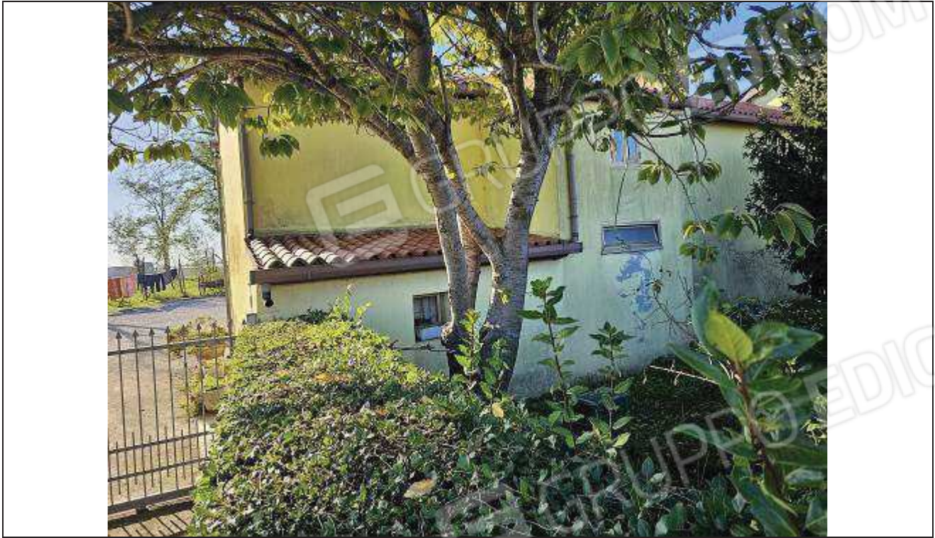
03 Vista del prospetto Nord-Est del fabbricato rurale (porzione residenziale);
