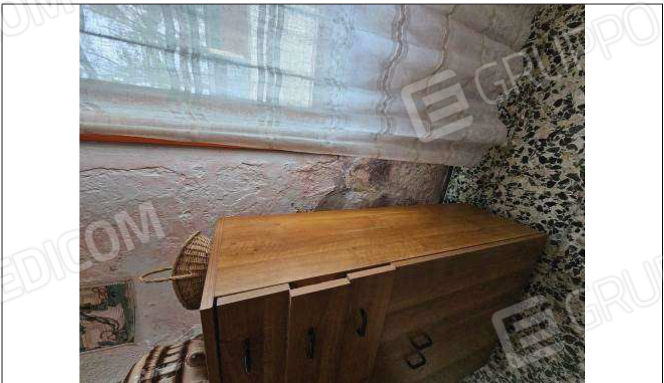
24 Altro particolare della muratura interna al piano terra del fabbricato rurale;
