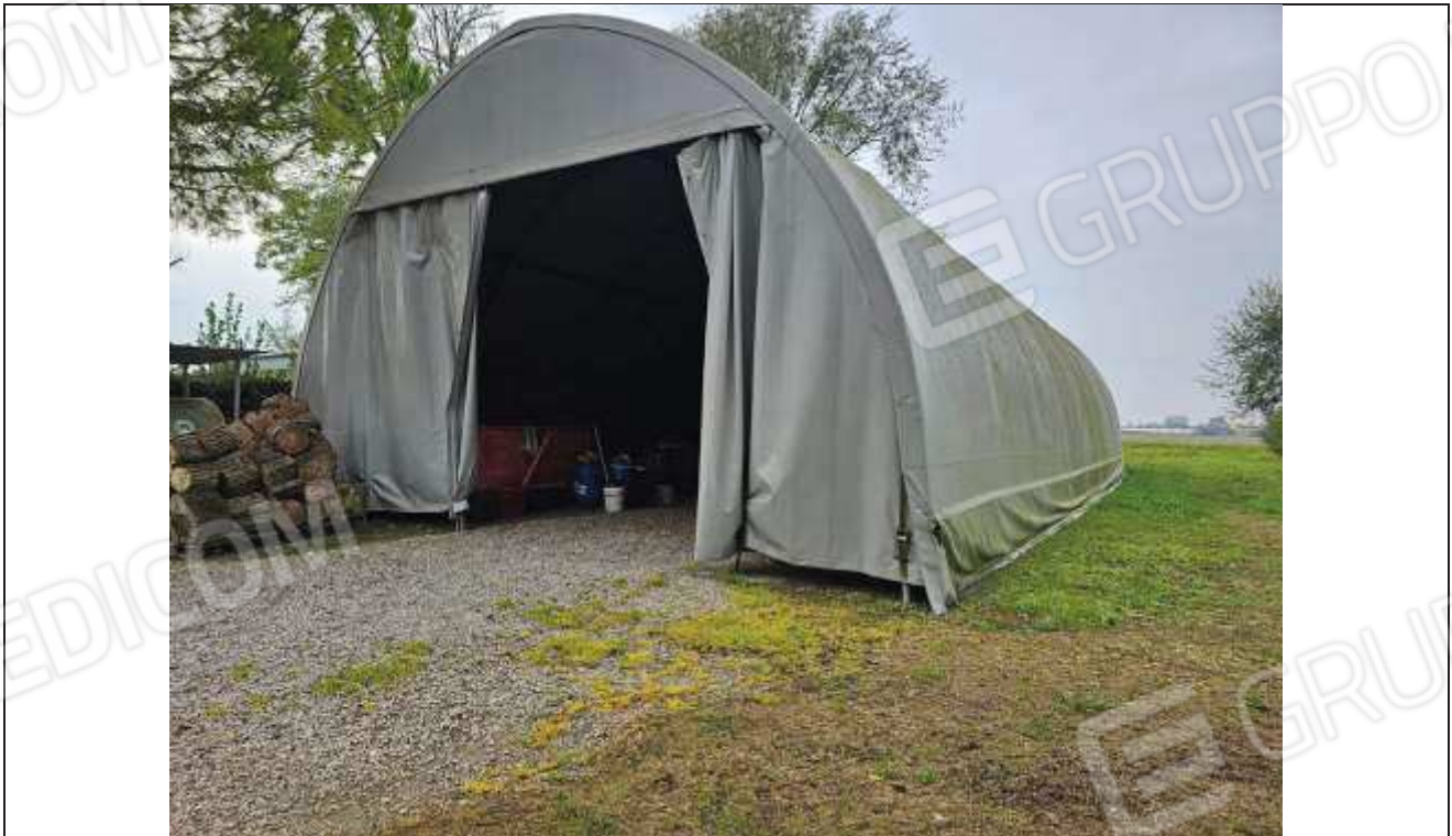
68 Vista della tensostruttura rimovibile adibita a deposito attrezzi e non autorizzata;
