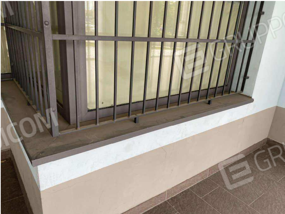
Foto 14 - particolare degli infissi
