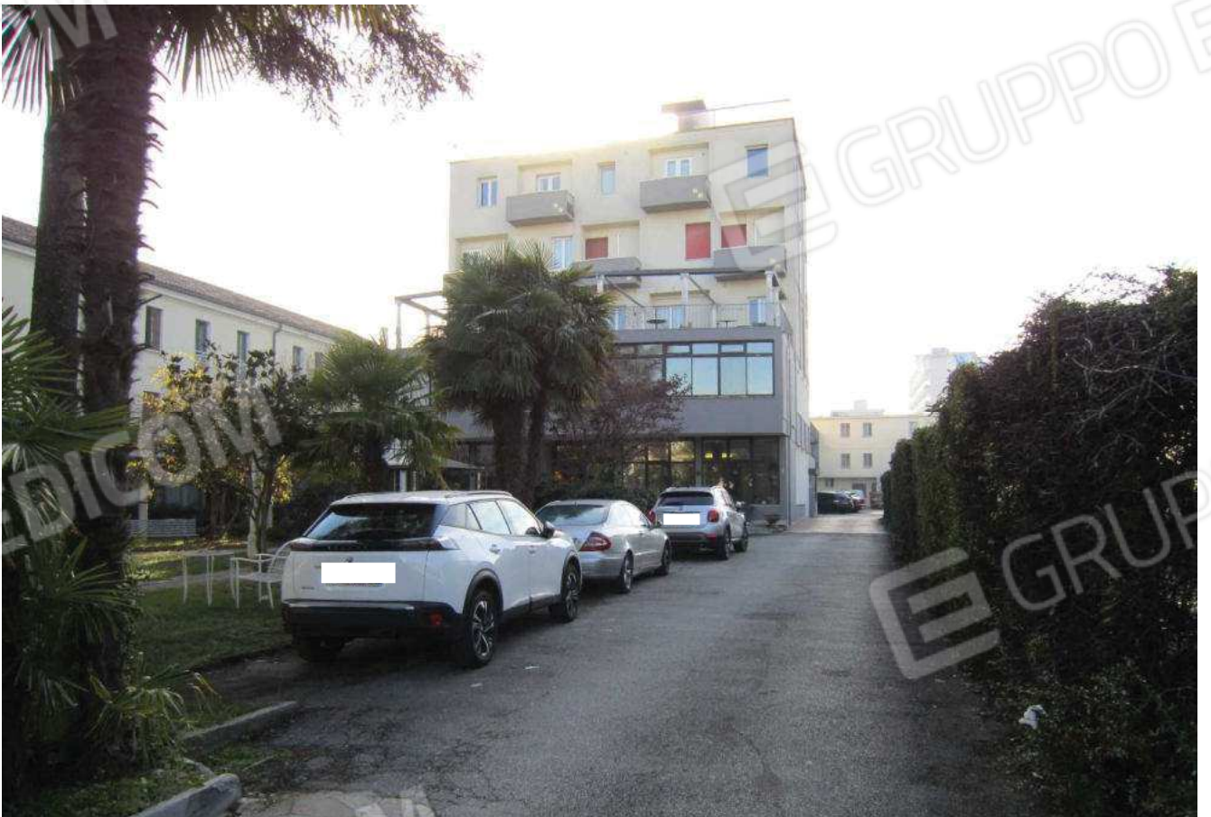
Veduta dell'ingresso carrabile verso l'hotel
