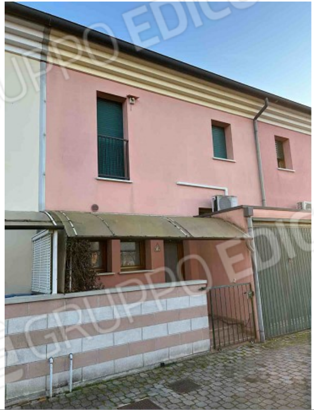
Vista dal retro (nord)
