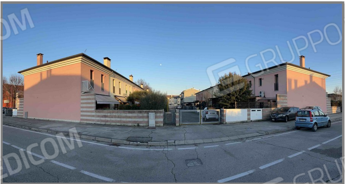
VISTA da via PRIMO MAGGIO n. 4
