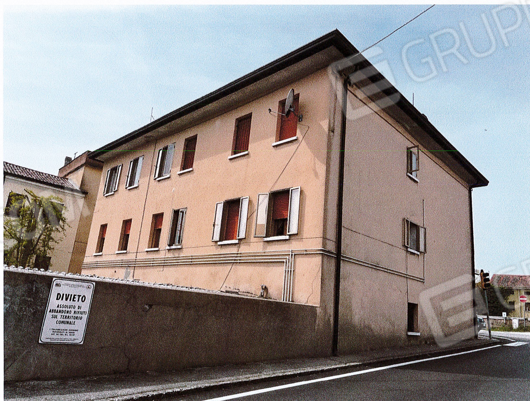
Vista del Fabbricato oggetto di E.I.
