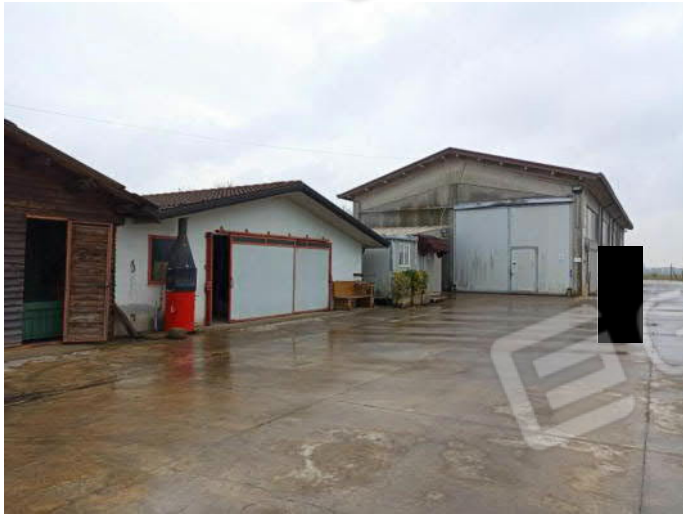
Fabbricato 1 e corpi accessori
