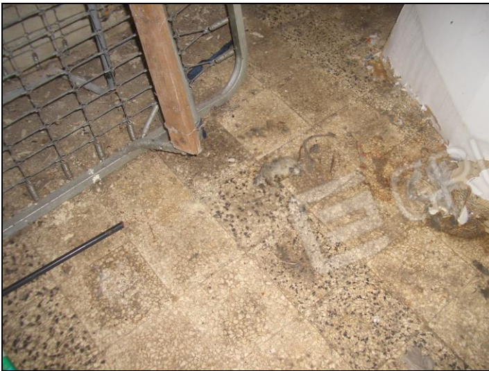
Vista interna P.T. porzione fabbricato civ. 57
