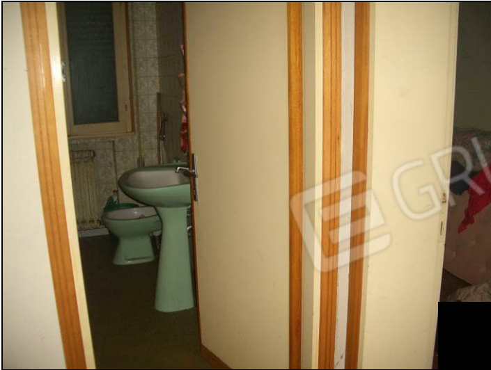
Vista interna P.1° porzione fabbricato civ. 55
