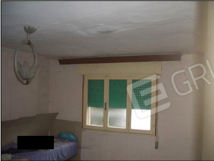
Vista interna P.1° porzione fabbricato civ. 55
