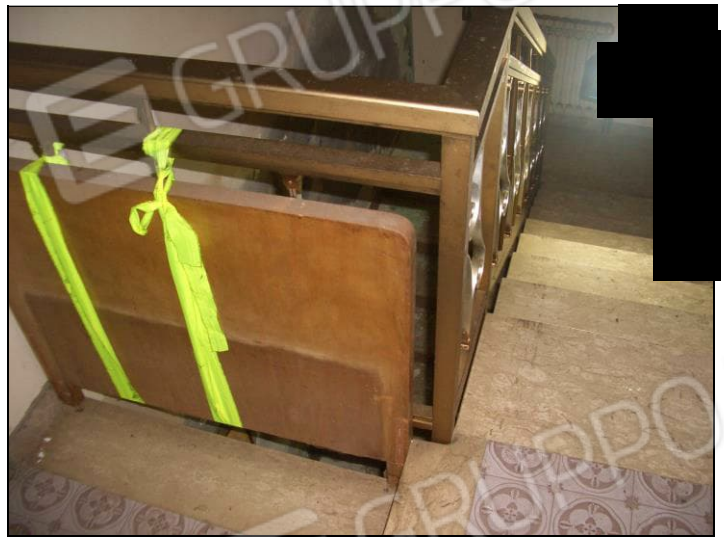
Vista interna P.1° porzione fabbricato civ. 55
