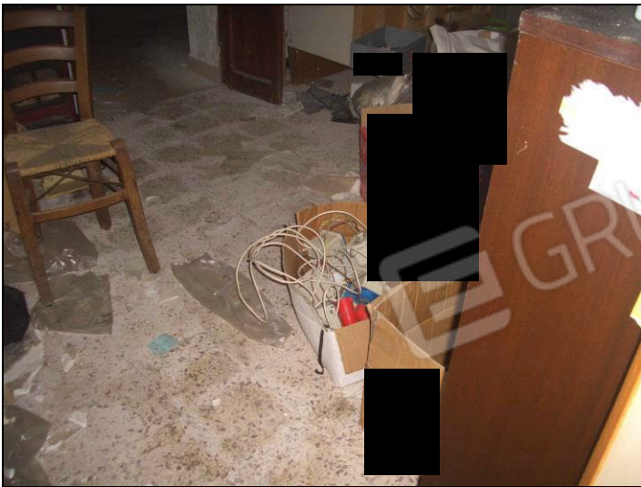
Vista interna P.T. porzione fabbricato civ. 55
