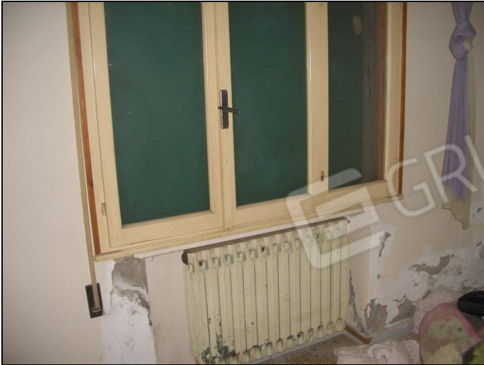
Vista interna P.T. porzione fabbricato civ. 55
