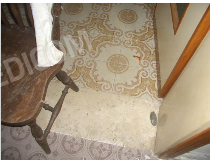
Vista interna P.T. porzione fabbricato civ. 55
