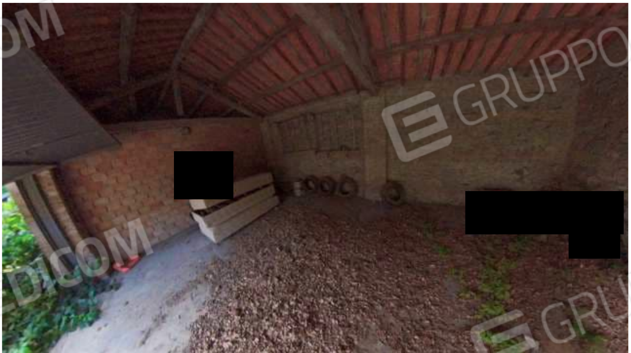
Figura 67 INTERNI GARAGES IN PERTINENZA A NORD DELLA VILLA
