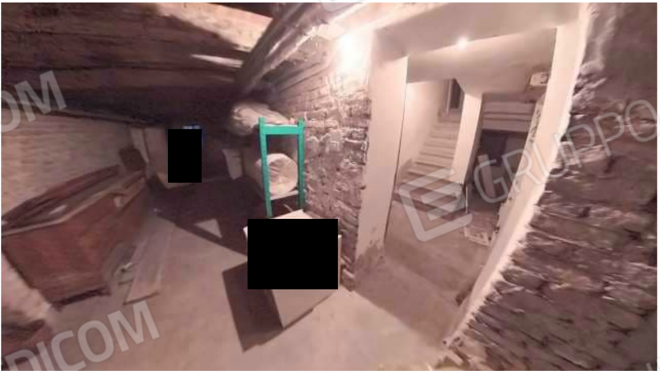
Figura 61 CANTINE AL PIANO SEMINTERRATO
