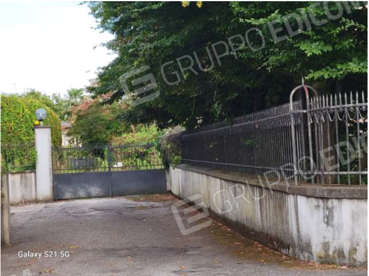
Figura 4 PARTICOLARE STRADELLO D'ACCESSO E INGRESSO CARRAIO DA VIA VALGRANDE
