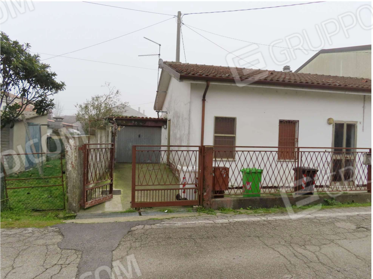
ACCESSO AL GARAGE
