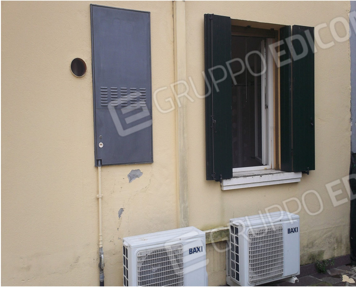
Vano Caldaia e Unità Esterne per condizionatori
