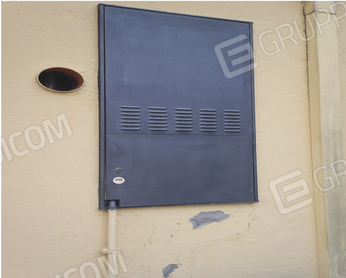
Vano Caldaia e Unità Esterne per condizionatori
