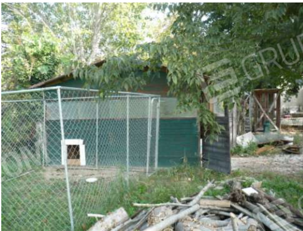
Locale ricovero attrezzi in legno dimensioni ml 4,20 x ml 11,00 Opera abusivamente realizzata da demolire PROSPETTO NORD
