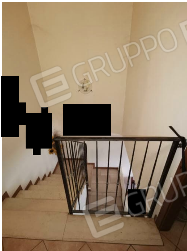
FOTOGRAFIA N.7 – particolare interno – vano scala
