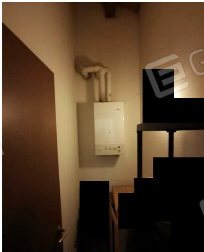
FOTOGRAFIA N.8 – particolare interno piano primo
