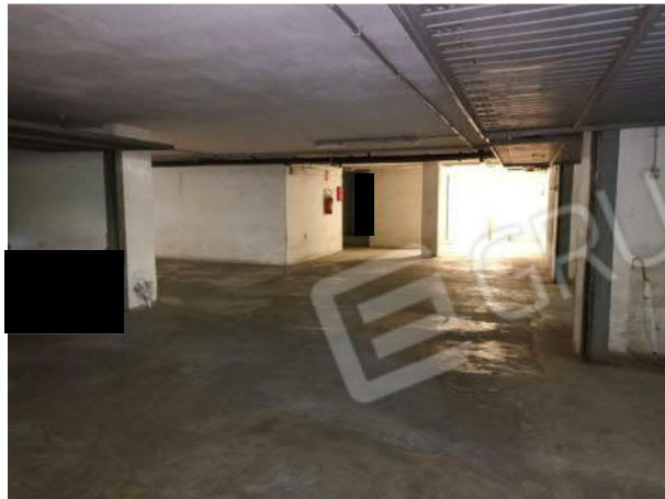
Particolare corsie accesso
