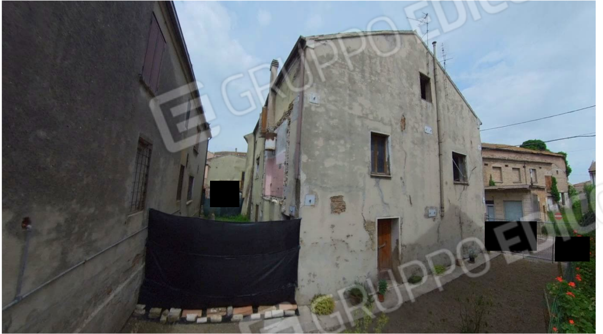
Figura 6 Veduta laterale Sud-Est
