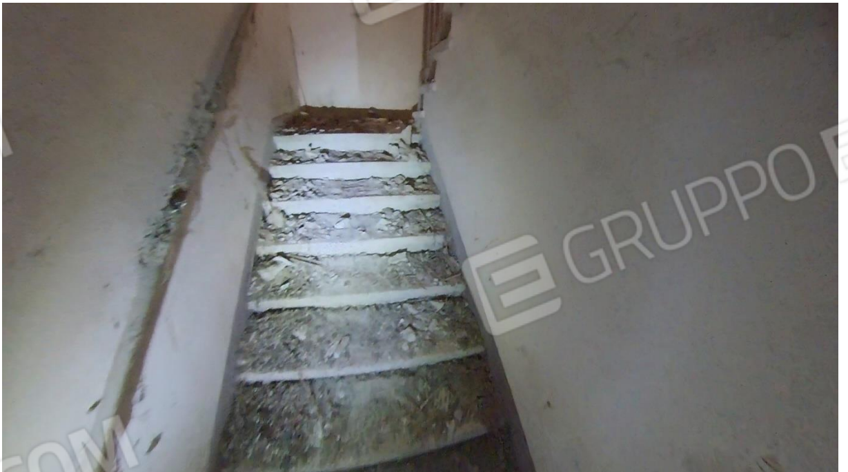
Figura 15 Interni Piano Terra
