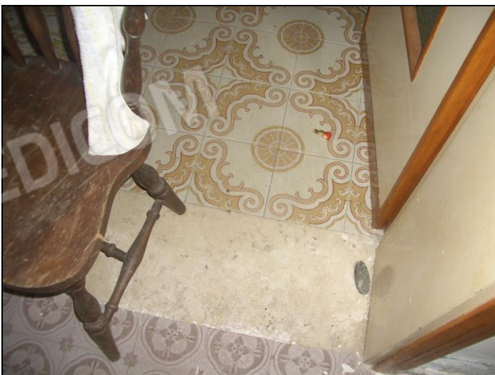
Vista interna P.T. porzione fabbricato civ. 55
