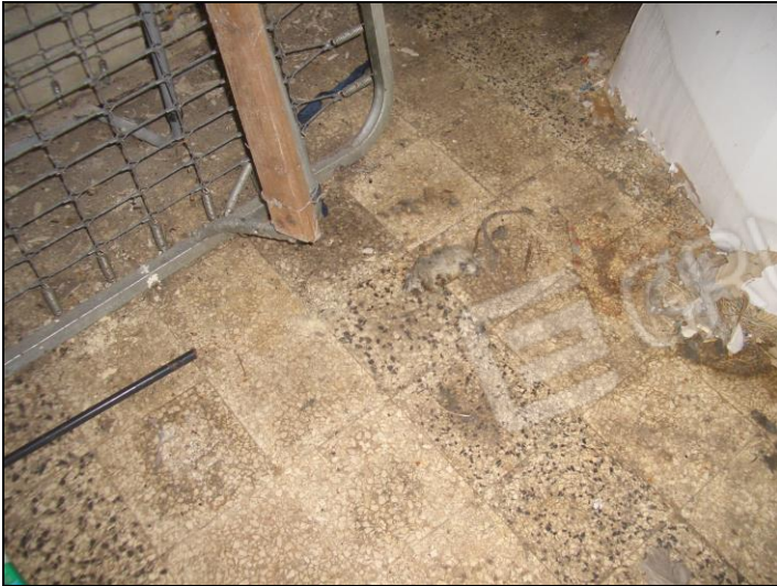
Vista interna P.T. porzione fabbricato civ. 57
