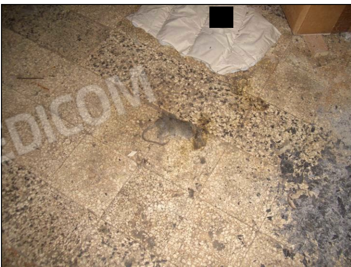
Vista interna P.T. porzione fabbricato civ. 57
