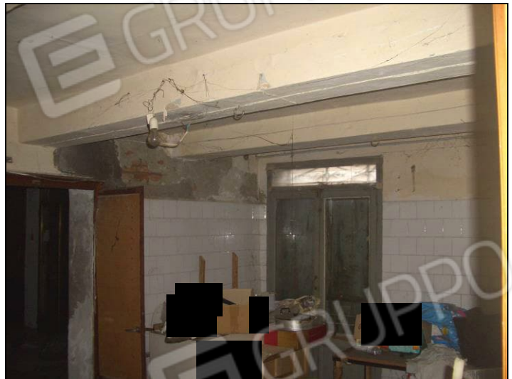
Vista interna P.T. porzione fabbricato civ. 55
