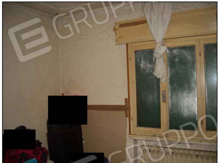
Vista interna P.T. porzione fabbricato civ. 55
