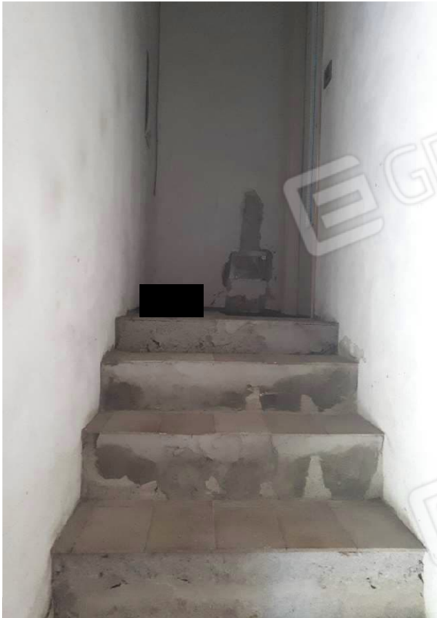
scala interna che collega il garage con il piano
