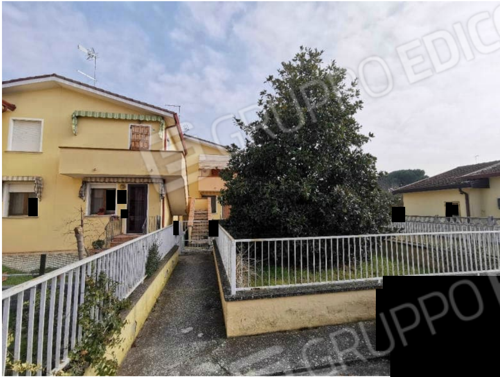
FOTOGRAFIA N. 1 -ingresso e cortile esclusivo al piano terra e posto auto
