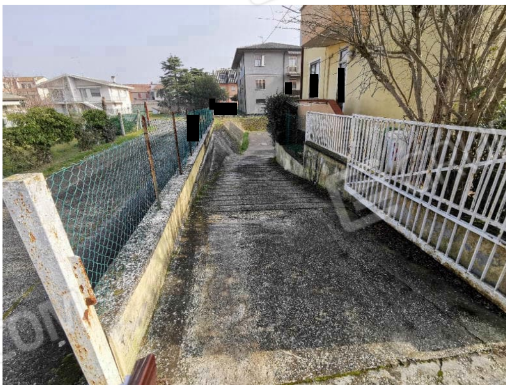
FOTOGRAFIA N. 8 -rampa di accesso ai garage
