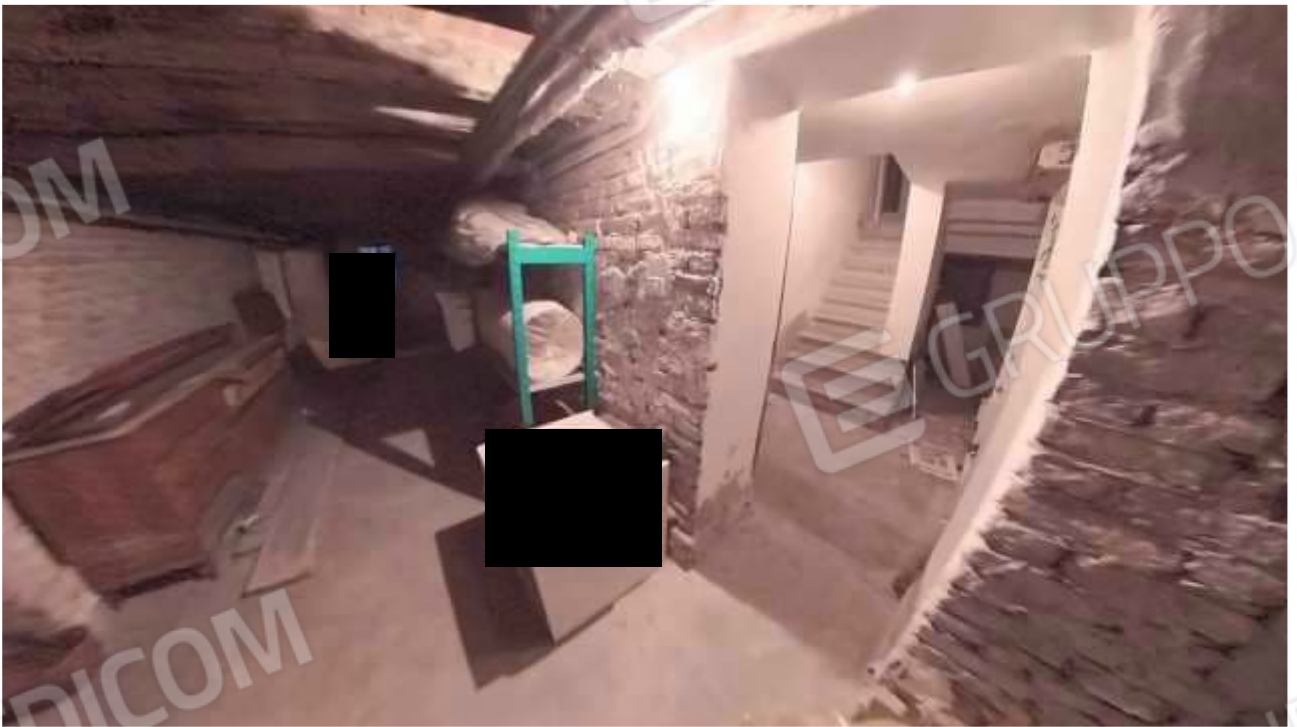
Figura 61 CANTINE AL PIANO SEMINTERRATO
