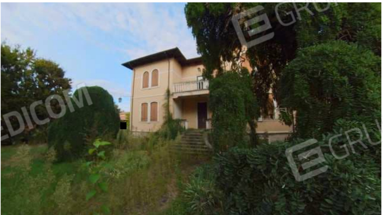
Figura 7 FACCIATA PRINCIPALE DELLA VILLA
