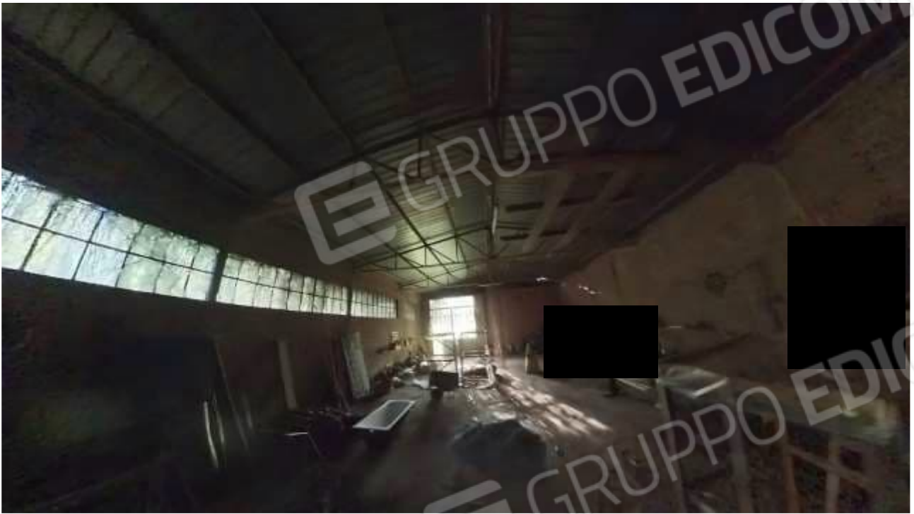
Figura 70MAGAZZINO IN PERTINENZA A NORD DELLA VILLA
