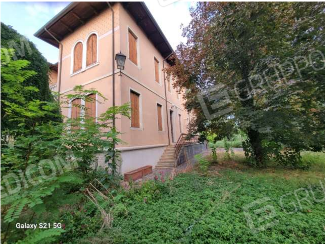
Figura 9 VEDUTA ESTERNA SUD-OVEST
