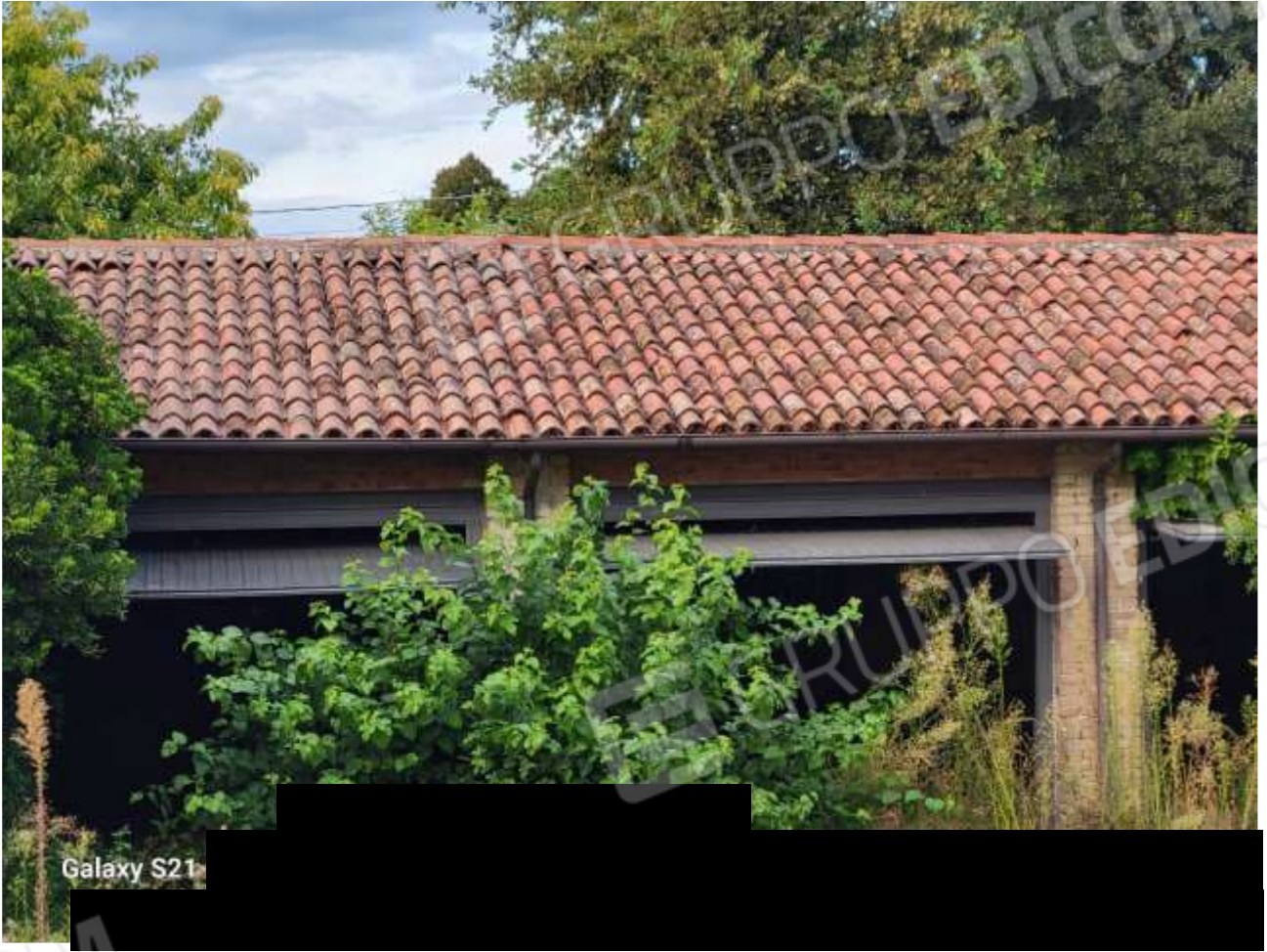
Figura 16 VEDUTA PERTINENZE GARAGES
