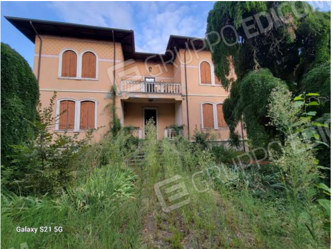
Figura 6 FACCIATA PRINCIPALE DELLA VILLA
