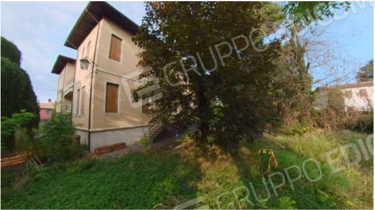
Figura 8 VEDUTA LATERALE SUD
