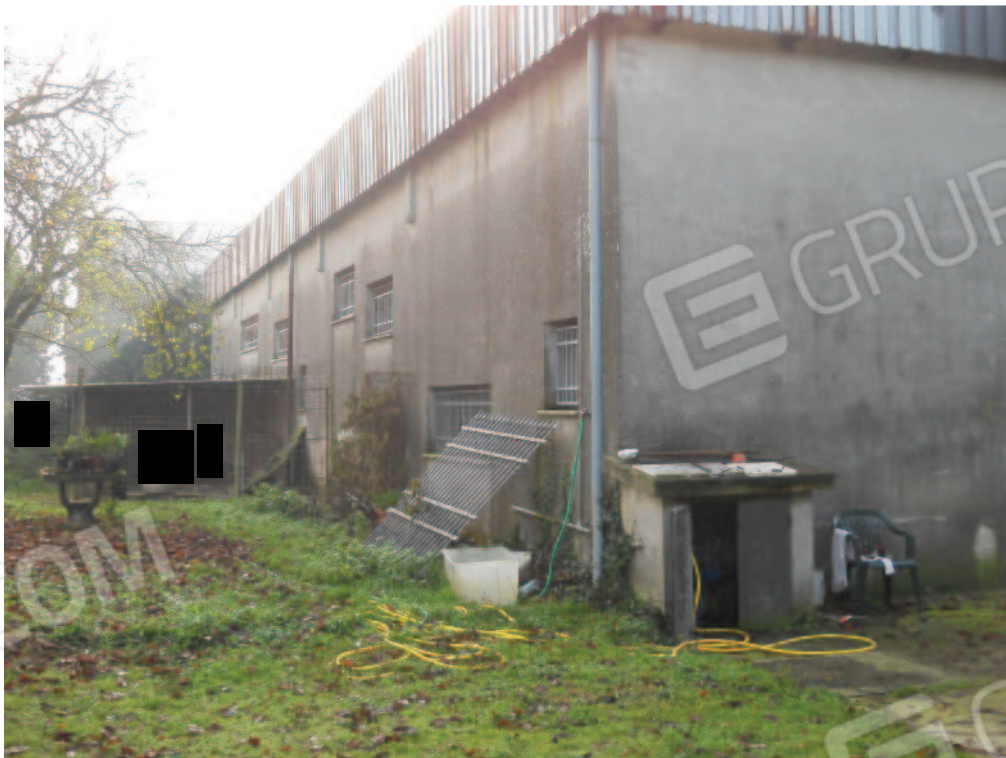
FOTOGRAFIA N.16 - particolare prospetto capannone
