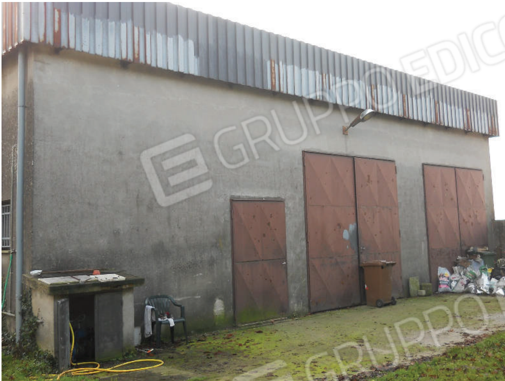
FOTOGRAFIA N.15 - particolare prospetto capannone
