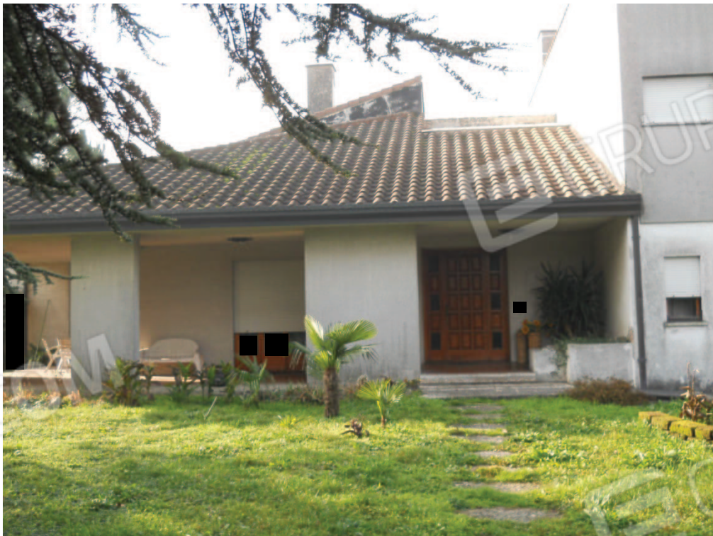
FOTOGRAFIA N.2 - particolare prospetto fabbricato residenziale
