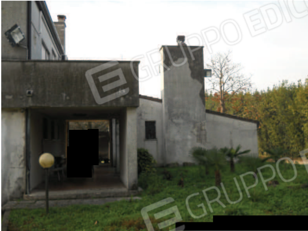
FOTOGRAFIA N.13 - particolare prospetto accessorio esterno
