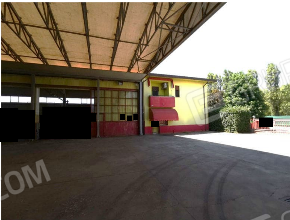
4. particolare prospetto est
