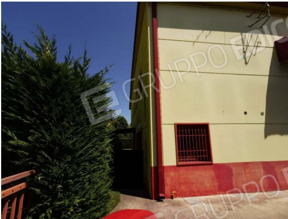
3. particolare prospetto sud-ovest
