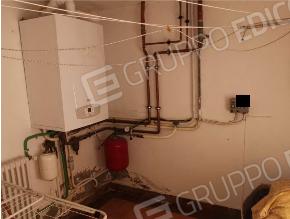
13 - particolare interno – piano terra
