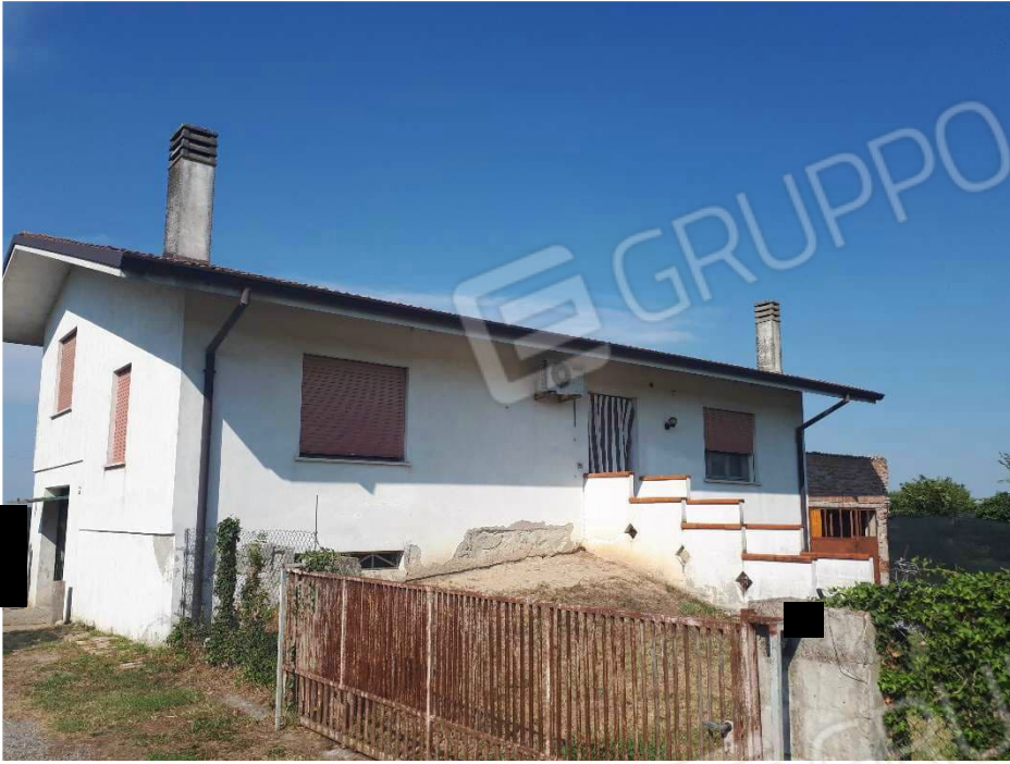
vista immobile lato sud
