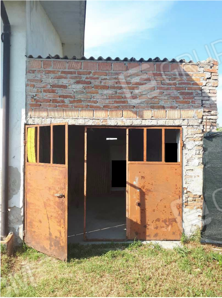
piccolo annesso dell'edificio da demolire
