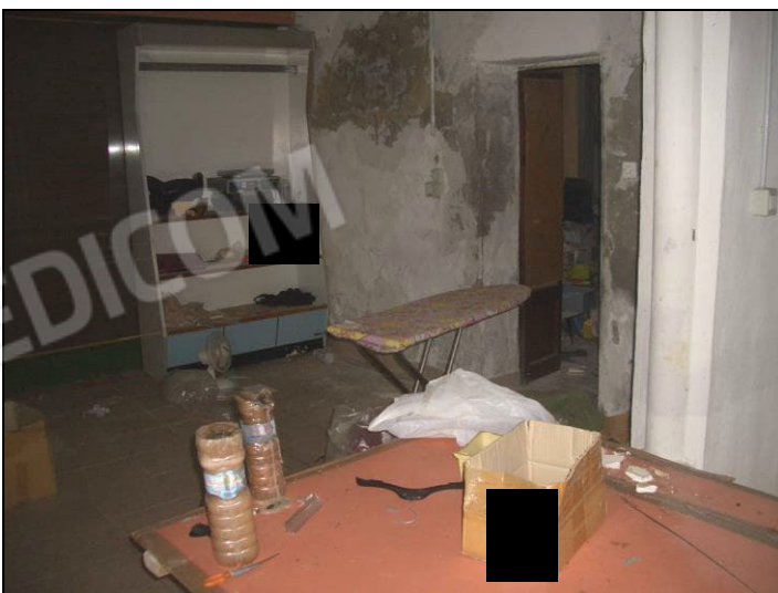
Vista interna P.T. porzione fabbricato civ. 57
