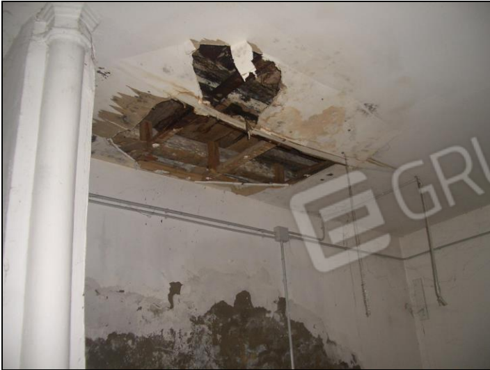
Vista interna P.T. porzione fabbricato civ. 57
