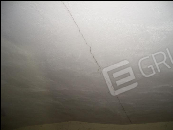
Vista interna P.1° porzione fabbricato civ. 55
