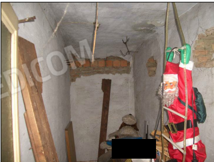
Vista interna P.1° porzione fabbricato civ. 55
