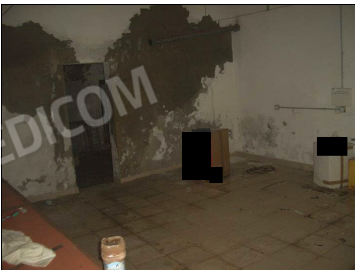
Vista interna P.T. porzione fabbricato civ. 57
