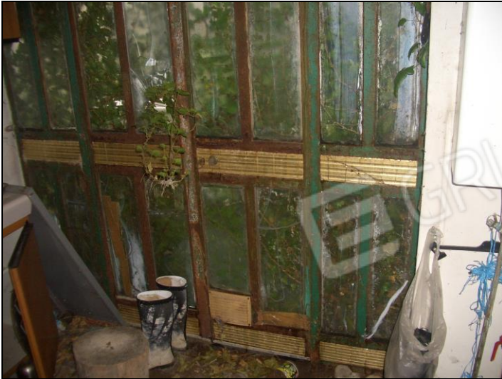
Vista interna P.T. porzione fabbricato civ. 55
