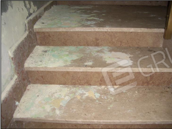
Vista interna P.T. porzione fabbricato civ. 55
