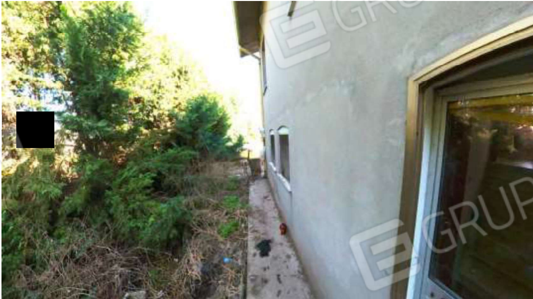
Figura 7 abitazione lato Ovest
