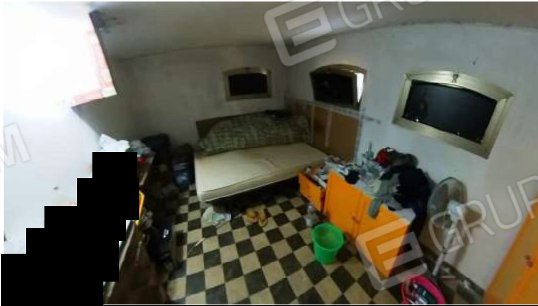
Figura 20 "cameretta" ricavata nella cantina seminterrato
