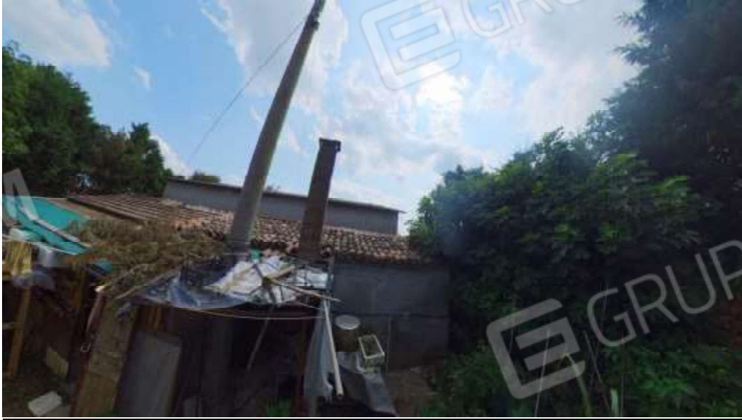
Figura 22 Laboratorio lato Nord
