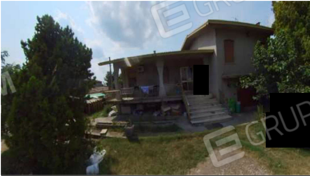
Figura 5 abitazione veduta Est
