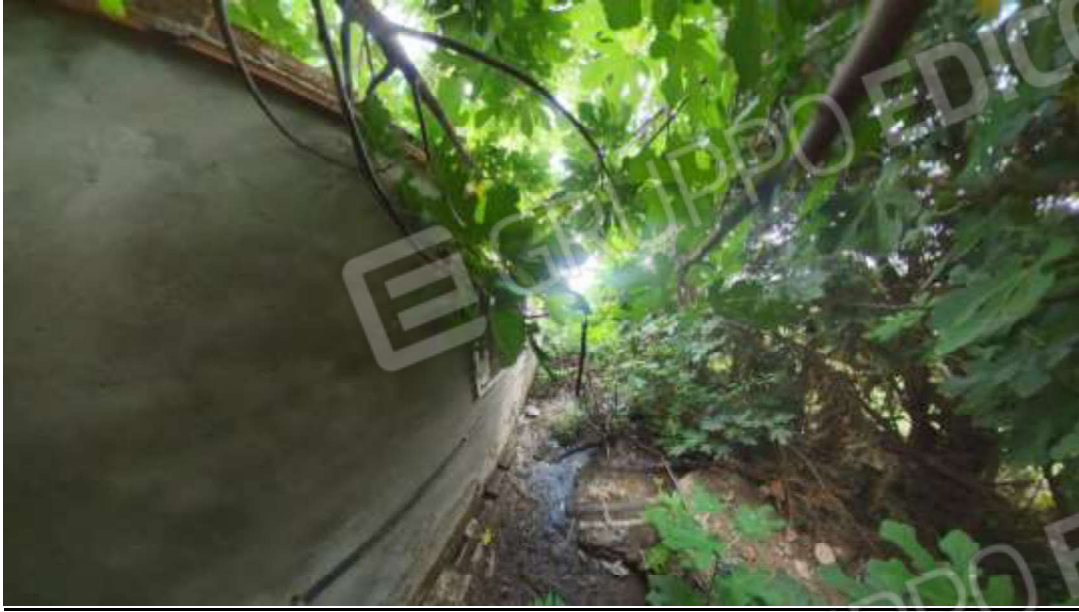
Figura 23 Laboratorio lato Ovest
