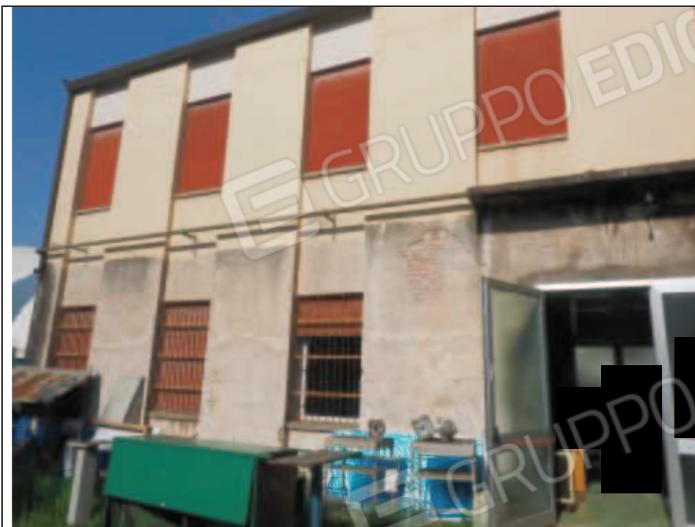
Figura 28 esterno blocco D
