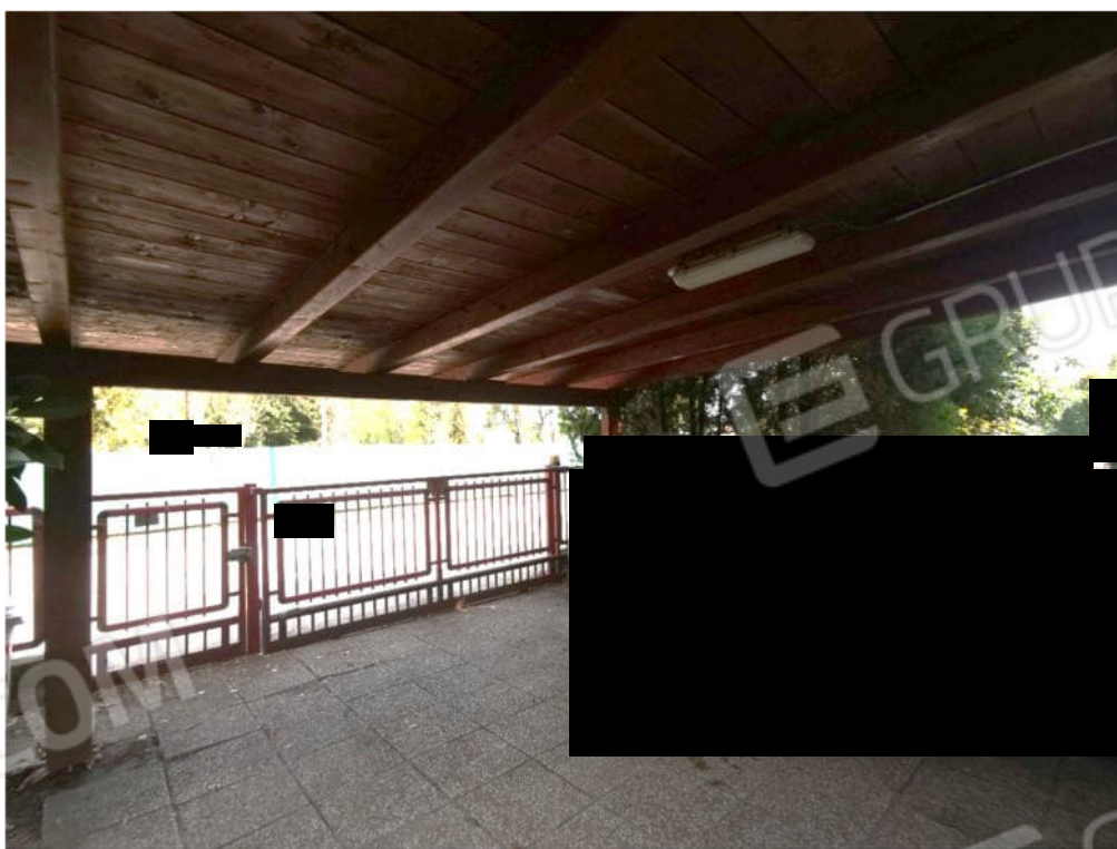
14. particolare pergolato antistante il garage
