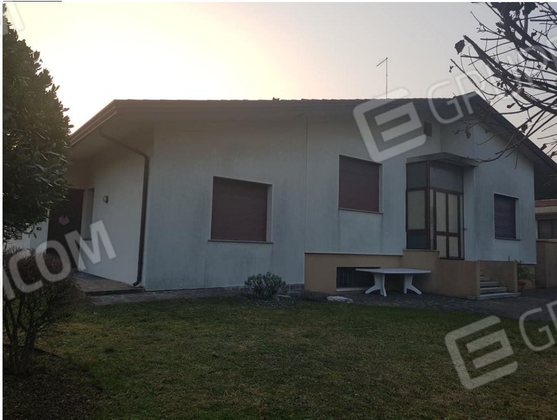
VISTA ESTERNA - FACCIATA NORD/EST
