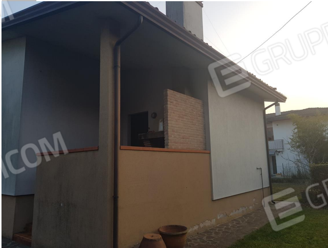
VISTA ESTERNA - FACCIATA NORD/OVEST
