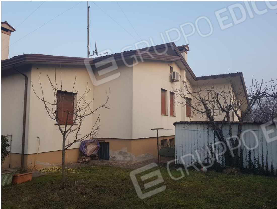
VISTA ESTERNA - FACCIATA NORD/OVEST
