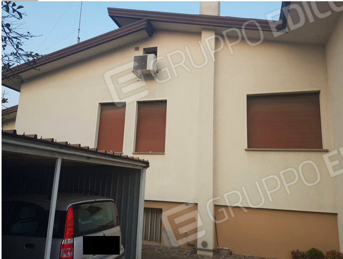
VISTA ESTERNA - FACCIATA SUD/OVEST
