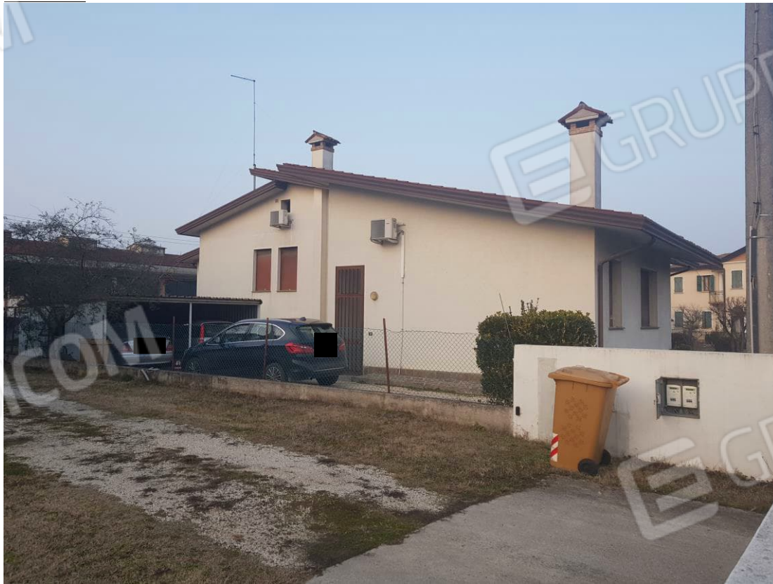
VISTA ESTERNA - FACCIATA SUD/OVEST
