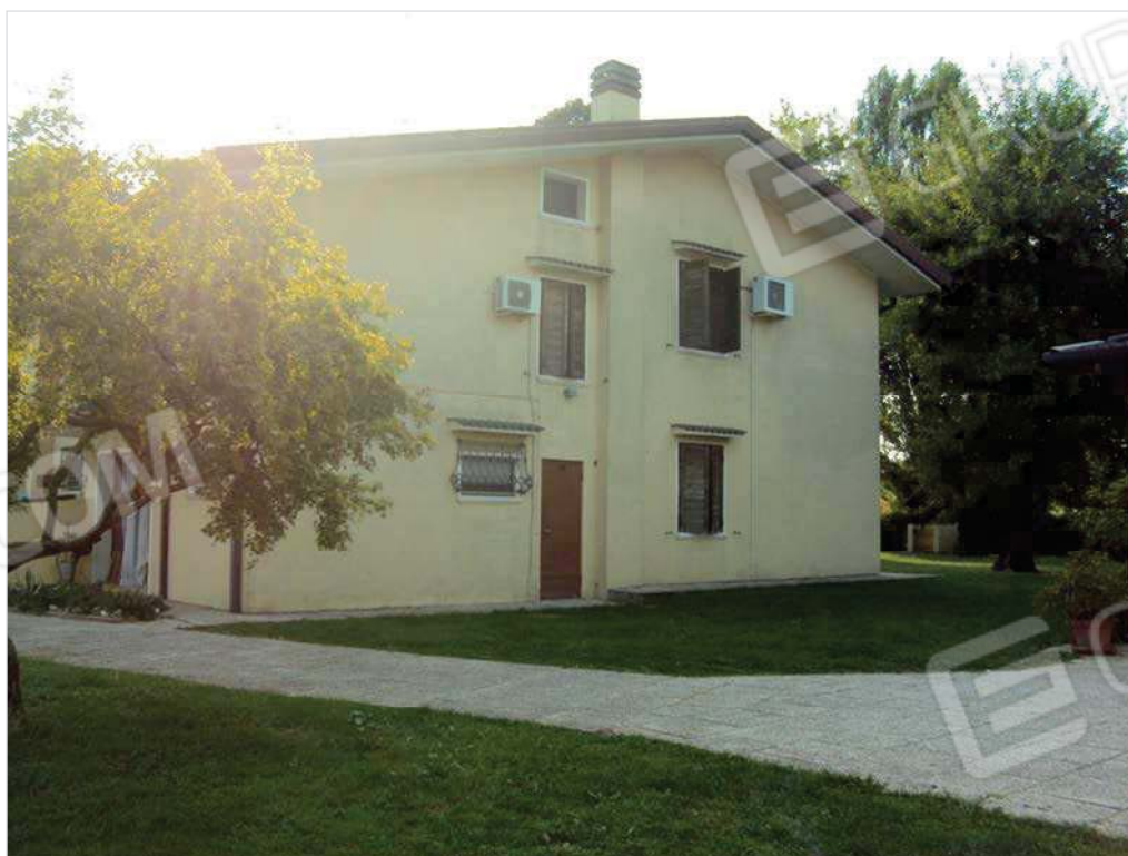
Foto n. 2: Prospetto nord-est dell'abitazione
