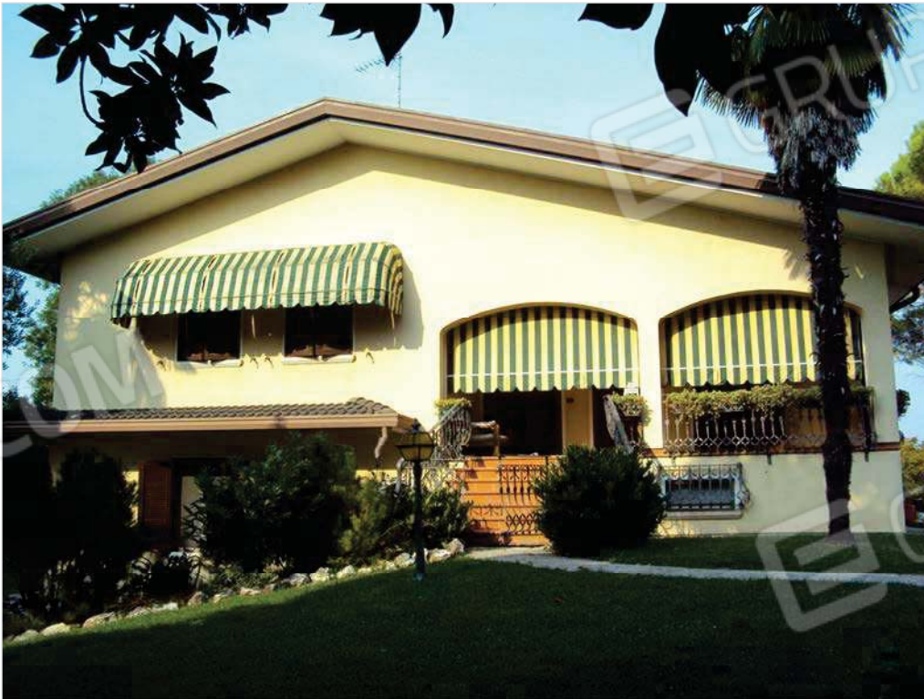
Foto n. 4: Prospetto sud-ovest dell'abitazione
