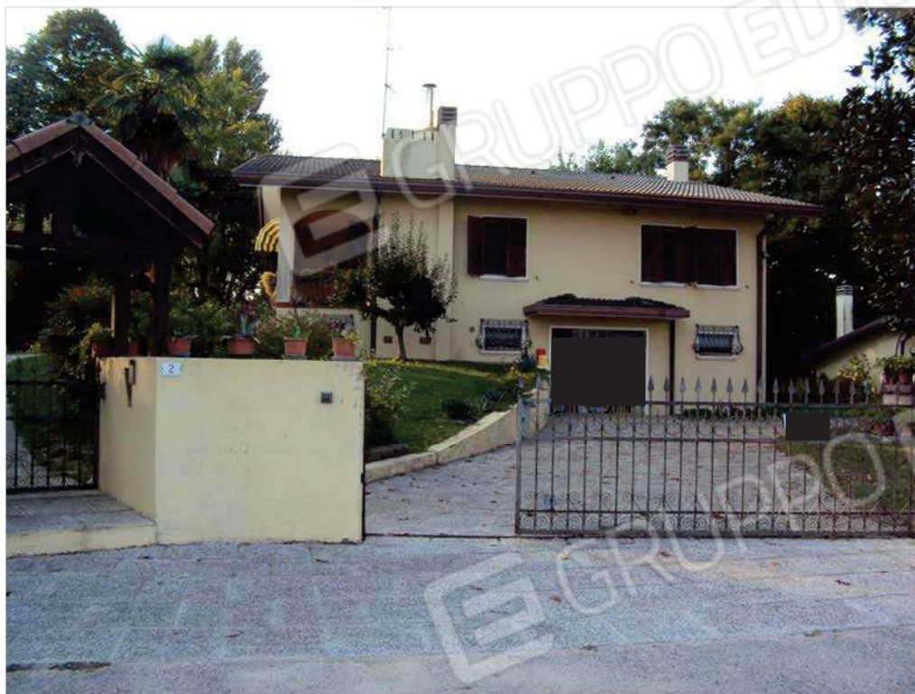
Foto n. 1: Prospetto sud-est dell'abitazione
