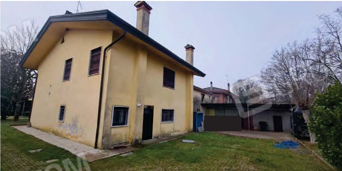
VISTA LATI EST E NORD E STRUTTURA ABUSIVA
