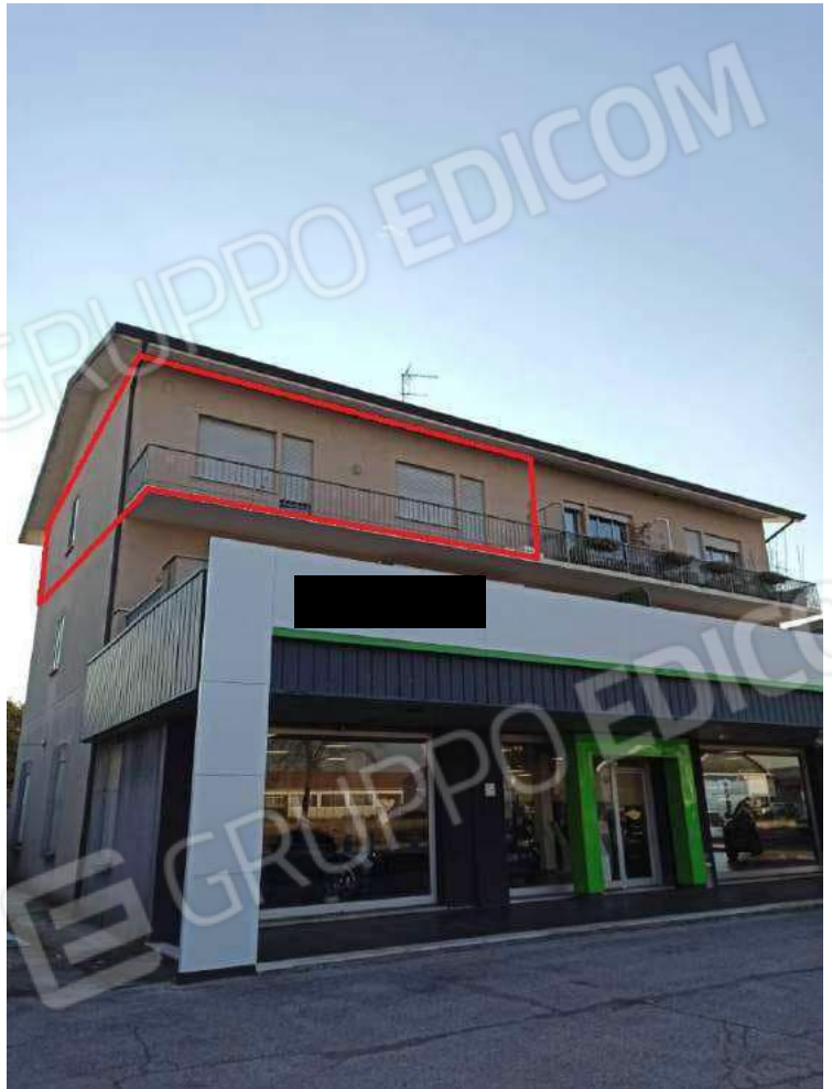
Vista fronte Ovest
