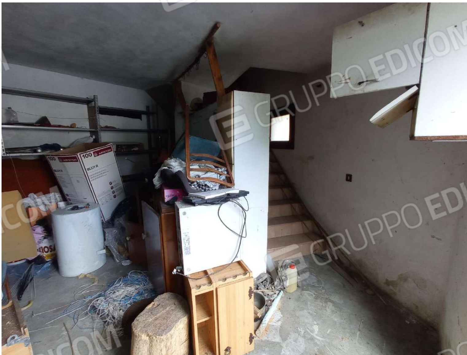
Foto 17 – Magazzino/garage piano terra fabbricato lotto 2
