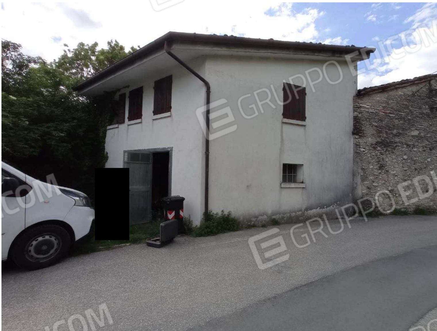
Foto 14 – Vista fabbricato lotto 2 lati nord e est
