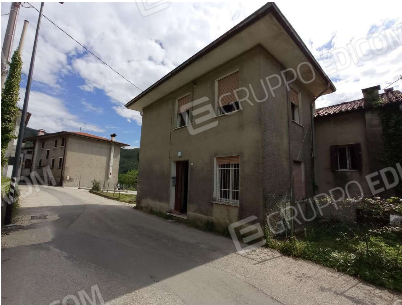
Foto 2 – Vista del fabbricato del lotto 1 lati nord e ovest
