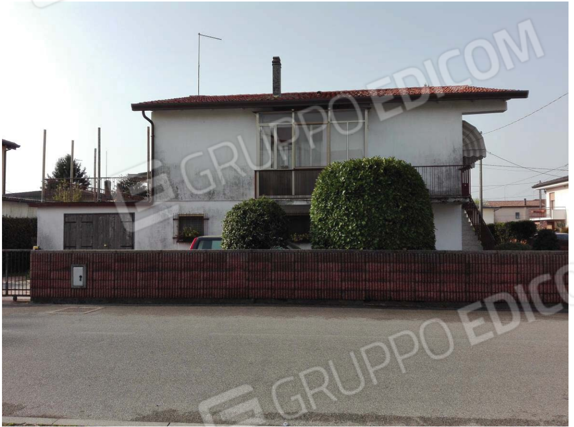
FOTO 4 IMMOBILE LATO NORD SU VIA BARACCA
