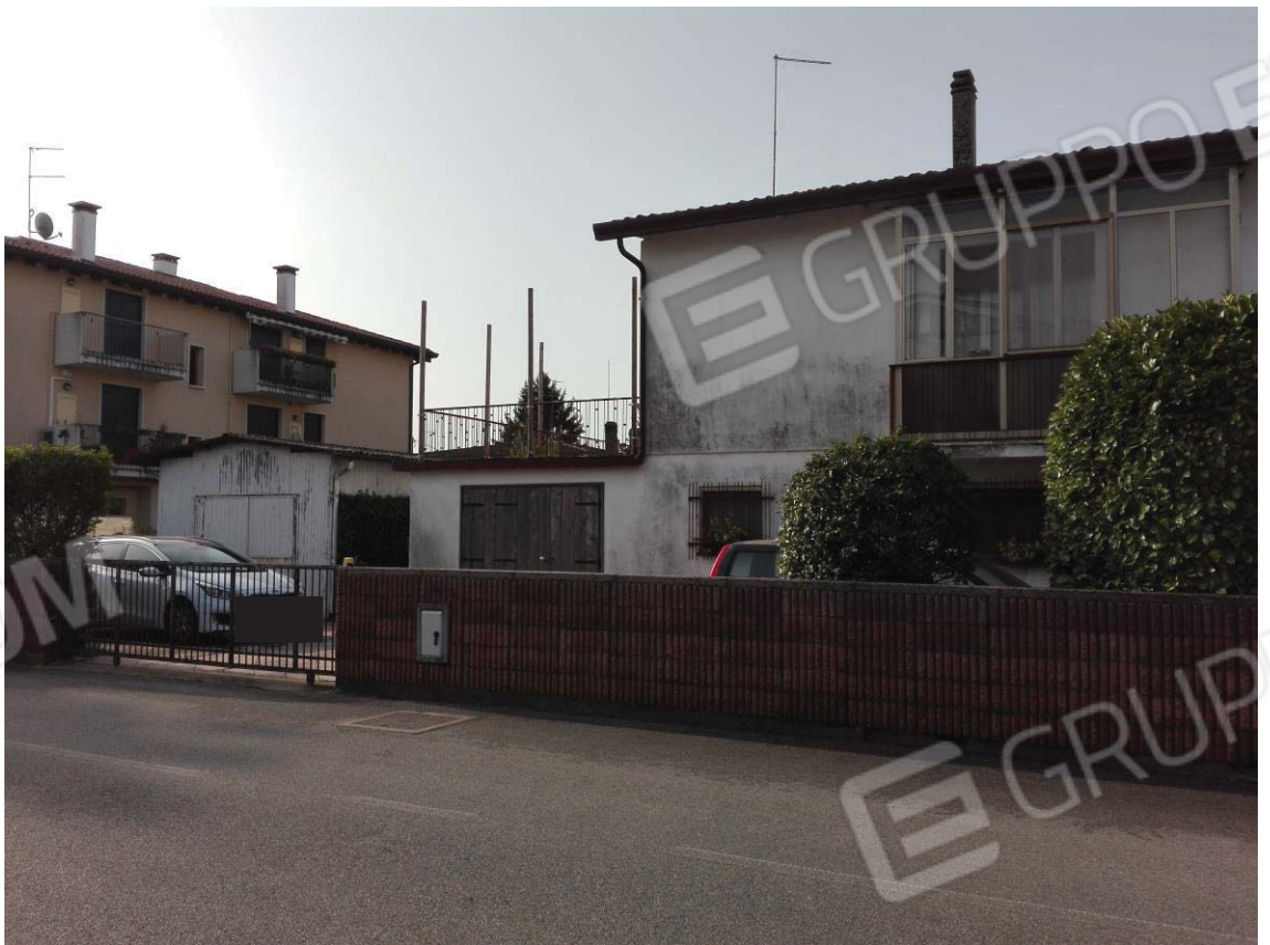
FOTO 5 ACCESSO CARRAIO SU VIA BARACCA
