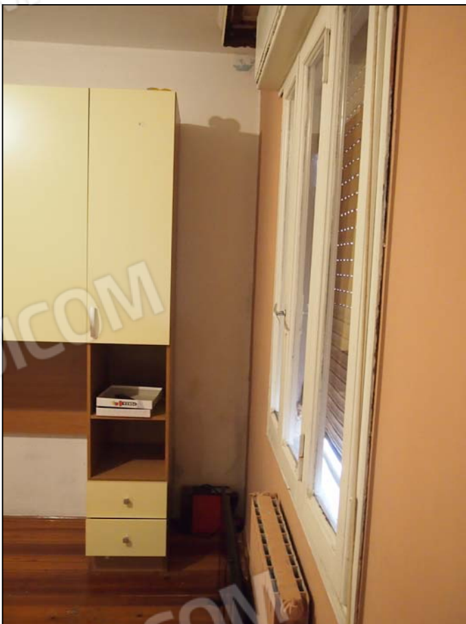
SECONDA CAMERA PARETE SUD
