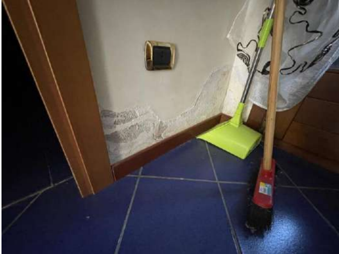
foto 7 particolare muratura del piano terra
