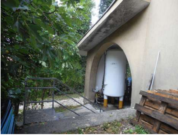
Foto 7 – Passaggio pedonale fronte sud
