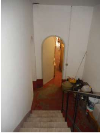
Foto 37 – scale porzione originaria
