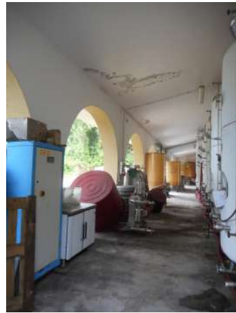
Foto 12 – portico/tettoia fronte ovest
