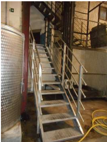
Foto 41 – locali piano interrato (porz. ampliata)
