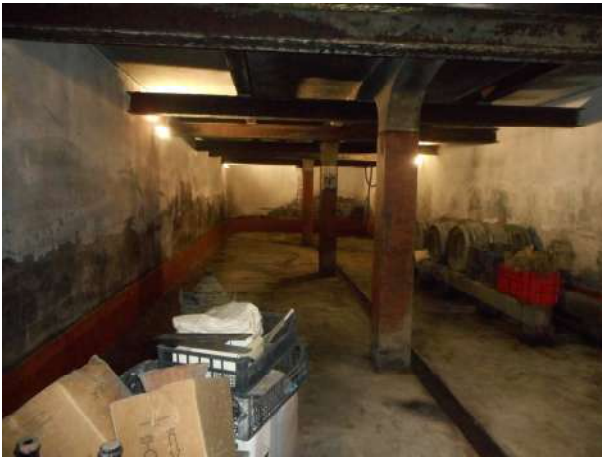
Foto 39 – locali piano interrato (porz. priginaria)
