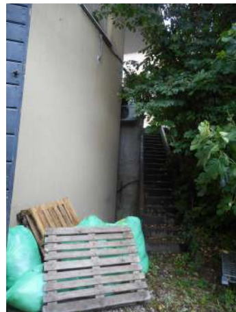
Foto 6 – Passaggio pedonale fronte sud
