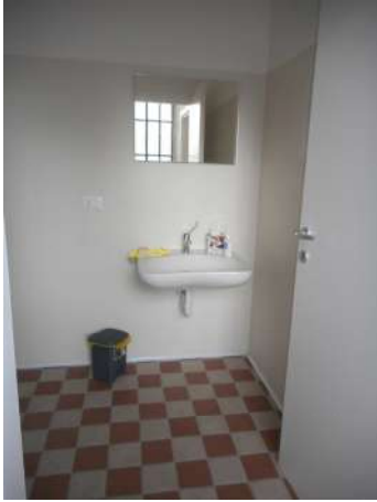
Foto 25 –bagni al Piano terra
