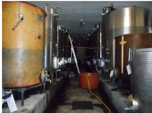
Foto 42 – locali piano interrato (porz. ampliata)
