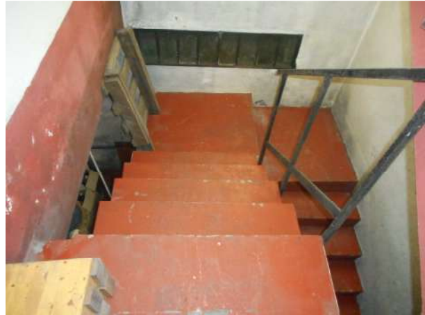
Foto 38 – scale porzione originaria
