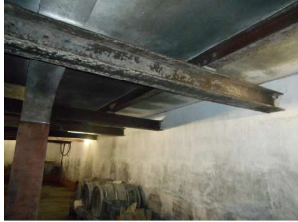
Foto 40 – locali piano interrato (porz. priginaria)
