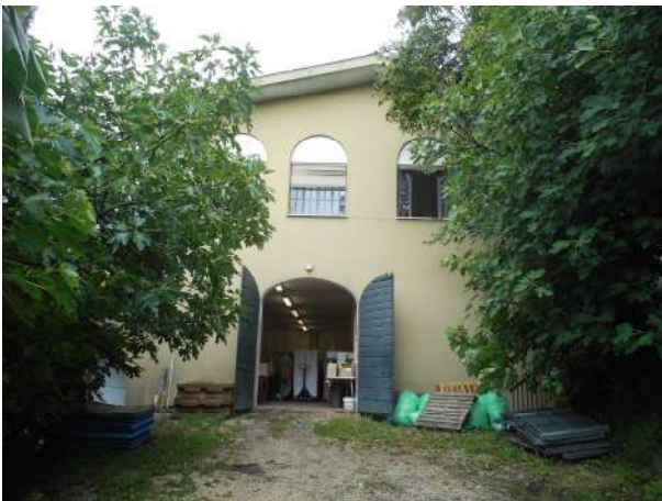
Foto 5 – accesso fabbricato da fronte sud
