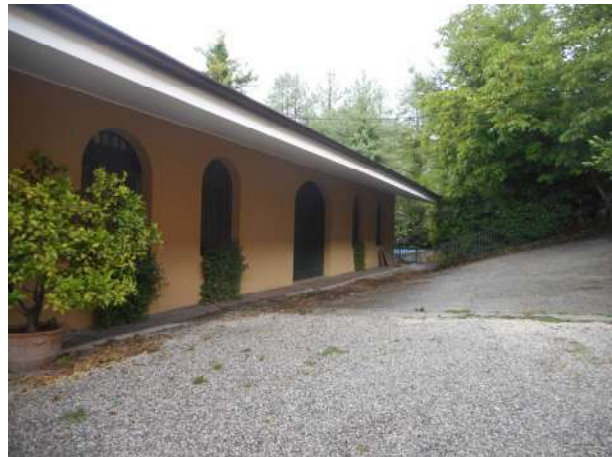
Foto 16 – fronte est (servitù)
