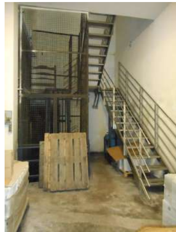
Foto 30 – scale e montacarichi per il piano seminterrato
