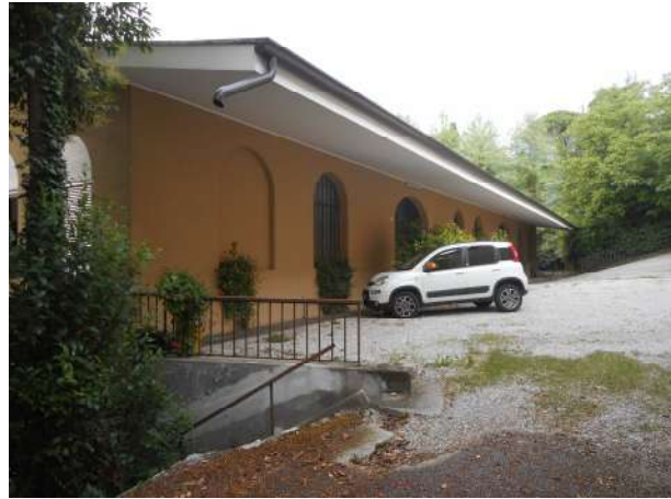
Foto 14 – fronte sud-est (passaggio pedonale)
