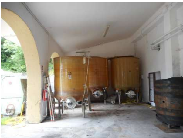
Foto 11 – portico/tettoia fronte ovest
