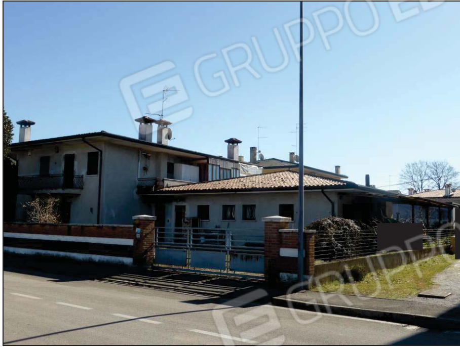
Foto n. 3 – Prospetti nord ed ovest del fabbricato
