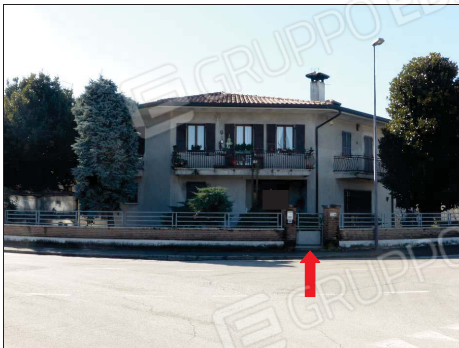
Foto n. 1 – Prospetto nord del fabbricato con dettaglio dell'accesso pedonale
