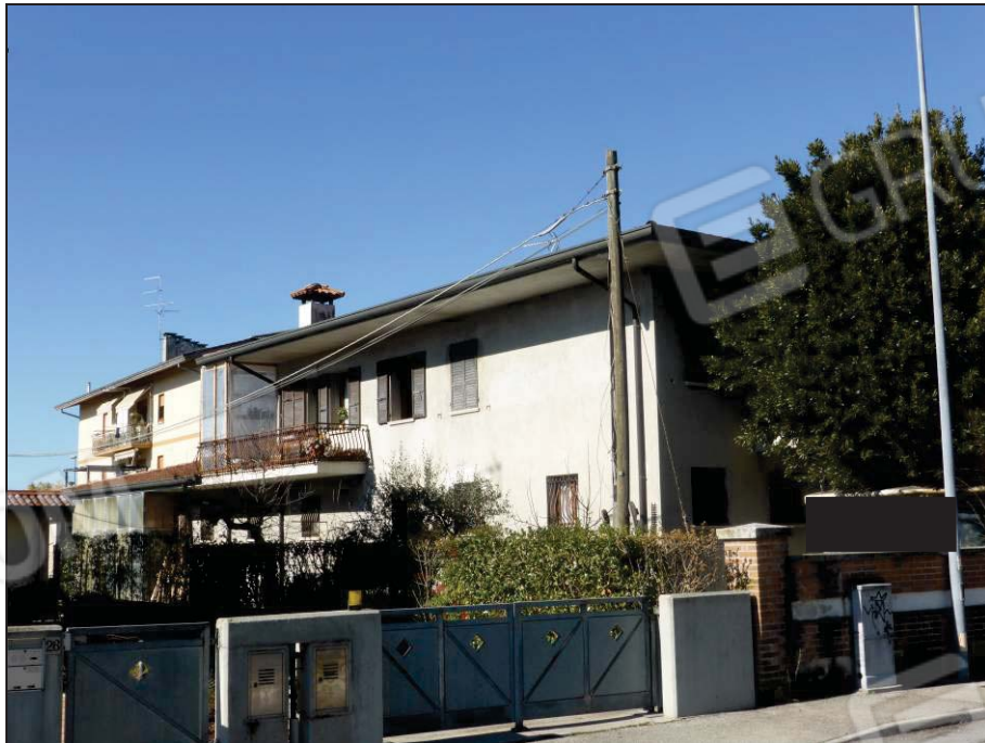
Foto n. 4 – Prospetti sud ed est del fabbricato
