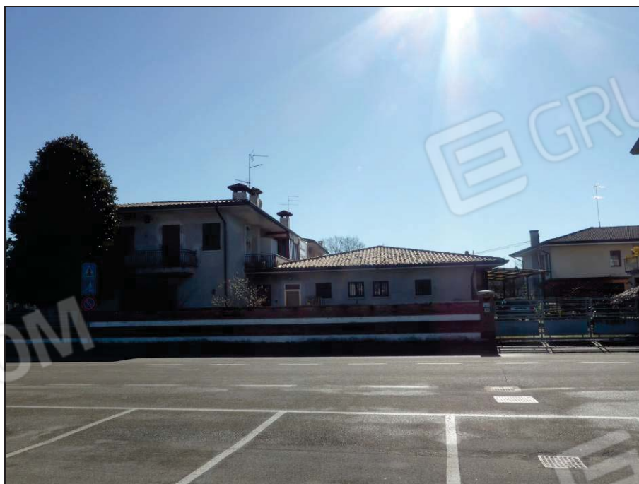
Foto n. 2 – Prospetto nord del fabbricato
