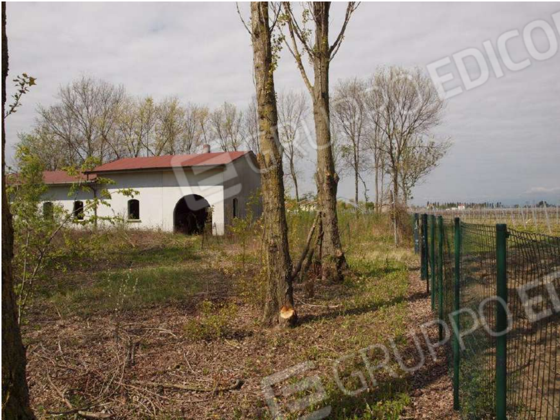
foto 3 vista esterna da nord-est
