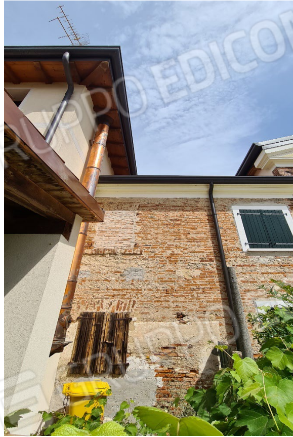
VISTA LATO SUD SU CONFINE
