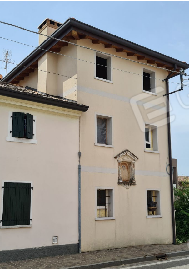
VISTA PROSPETTO EST
