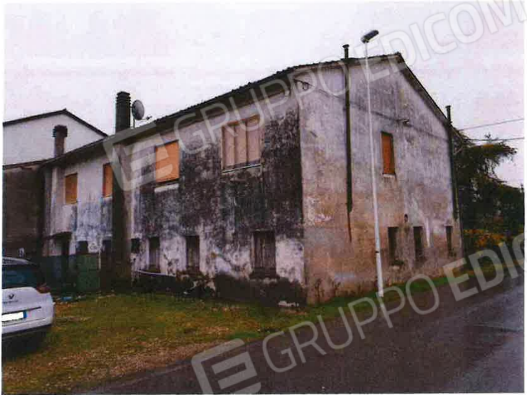
Vista nord-ovest fabbricato
