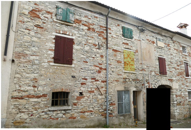
Fabbricato oggetto di pignoramento visto da Via Villa (facciata nord)
