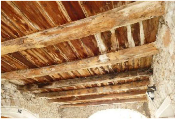
Soffitto del portico
