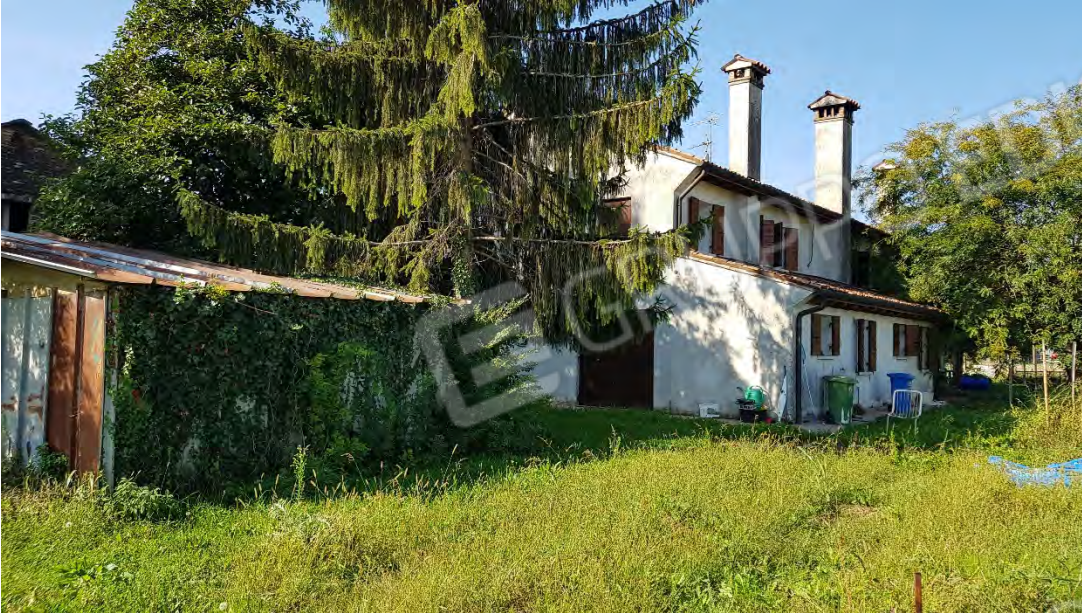
LATO EST E NORD
