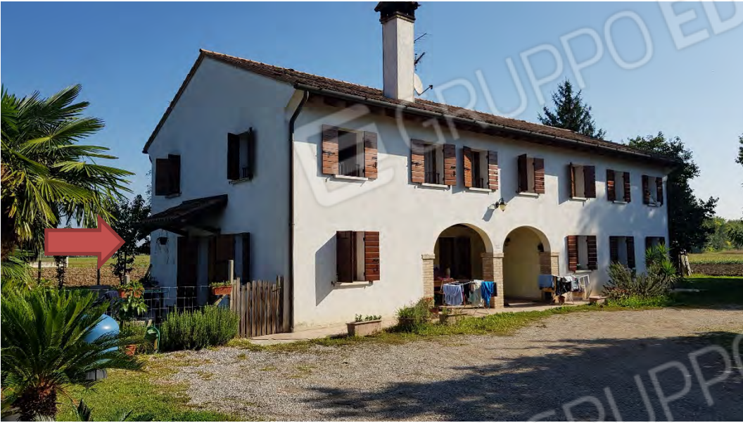
VISTA LATI SUD ED OVEST
