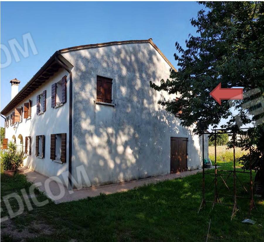
VISTA LATI SUD ED EST
