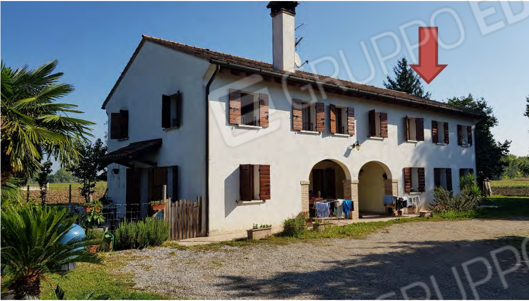
VISTA LATI SUD ED OVEST
